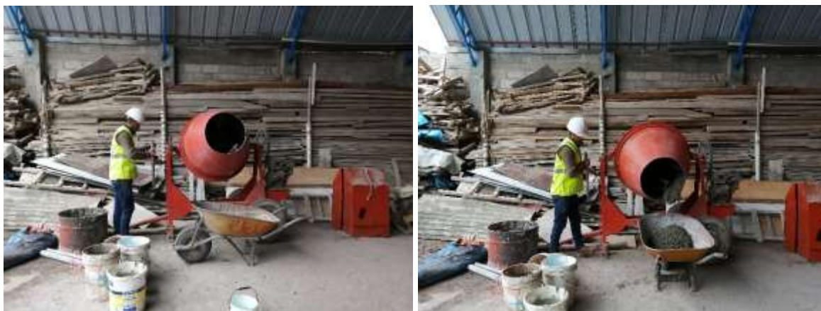
Ilustración N° 2: preparación de la mezcla
