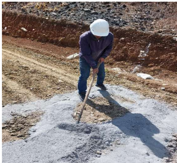
Fotografía 18: Disparcimiento de ceniza de bagazo de caña en las secciones. sector ceniza y cal. Prog. 0+090.00 - Prog. 0+102.40
