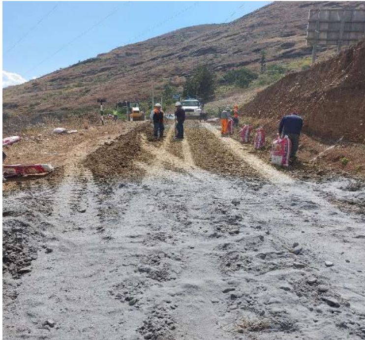
Fotografía 11: Ceniza de bagazo de caña esparcida en las secciones. sector ceniza. Prog. 0+015.00 - Prog. 0+030.00
