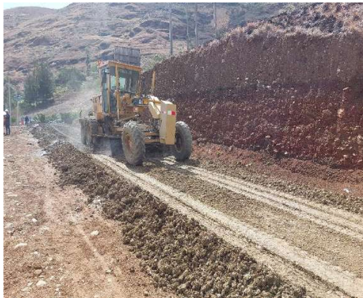
Fotografía 24: Extendido del material de afirmado con la motoniveladora sector ceniza y cal. Prog. 0+090.00 - Prog. 0+102.40
