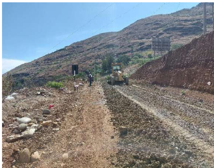
Fotografía 20: Mezclado del material de afirmado y ceniza de bagazo de caña con la motoniveladora sector ceniza. Prog. 0+030.00 - Prog. 0+040.80
