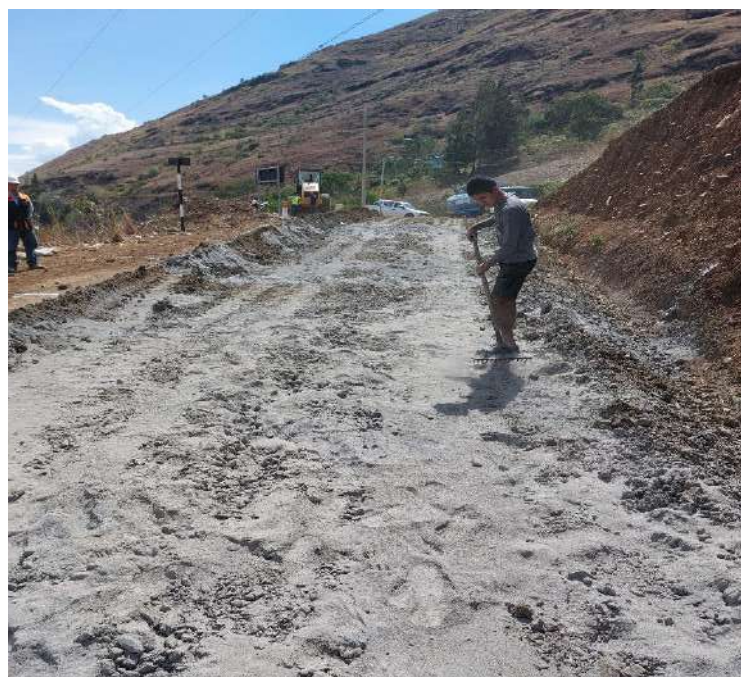
Fotografía 16: Dispersamiento de ceniza de bagazo de caña en las secciones. sector ceniza. Prog. 0+030.00 - Prog. 0+040.80
