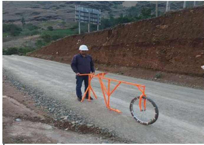
equipo merlín Prog, 0+ 015.00 – 0+030.00 (Tramo con afirmado + CBCA)
