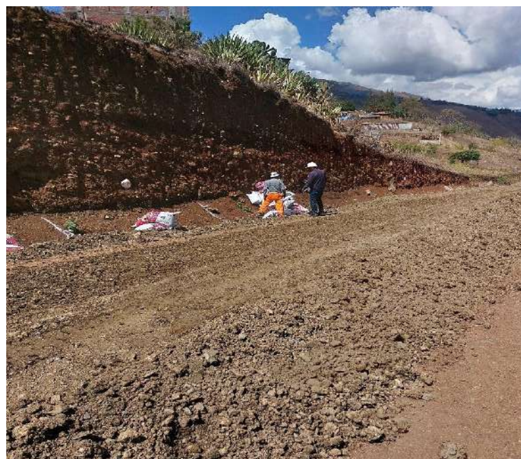
Fotografía 10: Distribución de costales de ceniza y bolsas de cal en las secciones según dosificación Prog. 0+090.00 - Prog. 0+102.40
