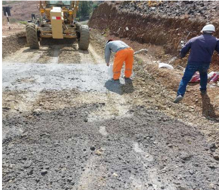
Fotografía 14: Esparcimiento de cal en las secciones. sector ceniza y cal. Prog. 0+090.00 - Prog. 0+102.40
