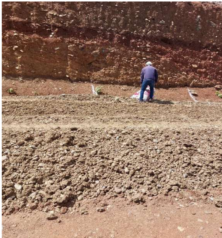
Fotografía 8: Distribución de costales de ceniza de bagazo de caña en las secciones sector ceniza Prog. 0+030.00 - Prog. 0+040.80.
