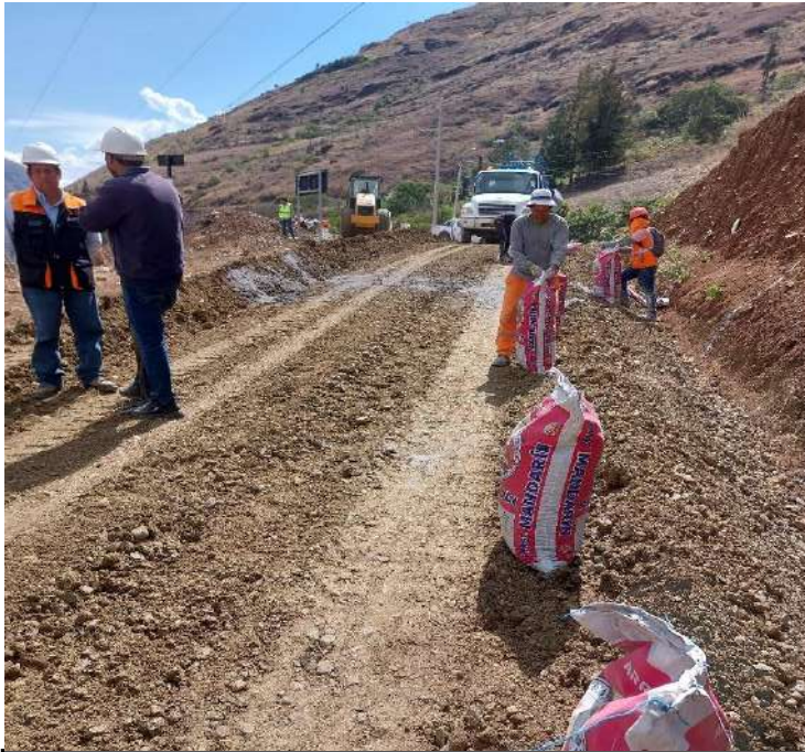
Fotografía 5: costales de ceniza de bagazo de caña preparados para ser esparcidos en las secciones. sector ceniza. Prog. 0+015.00 - Prog. 0+030.00
