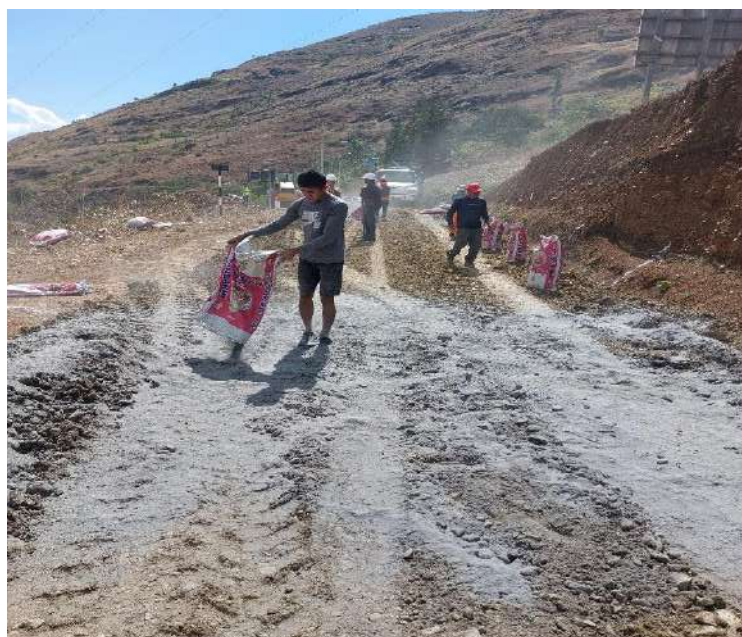
Fotografía 12: Ceniza de bagazo de caña esparcida en las secciones. sector ceniza. Prog. 0+030.00 - Prog. 0+040.80
