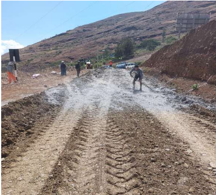
Fotografía 15: Dispersamiento de ceniza de bagazo de caña en las secciones. sector ceniza. Prog. 0+015.00 - Prog. 0+030.00
