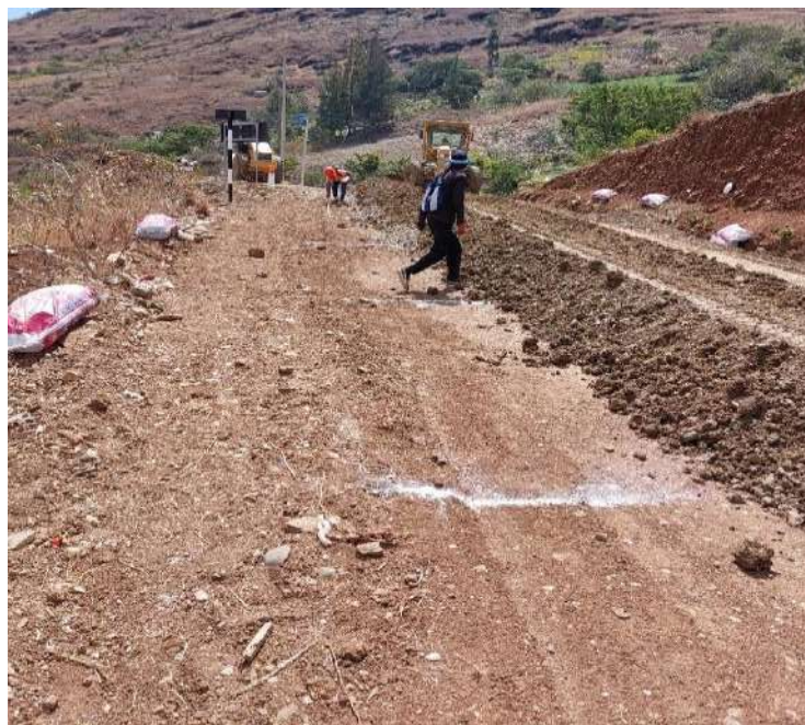
Fotografía 4: Trazo de secciones de 4.725 \times 4.3 m 2 Prog. 0+030.00 - Prog. 0+040.80, sector ceniza bagazo de caña
