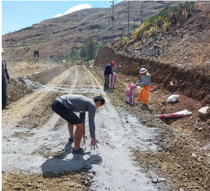
Fotografía 17: Disparcimiento de ceniza de bagazo de caña en las secciones. sector ceniza y cal. Prog. 0+076.60 - Prog. 0+90.00
