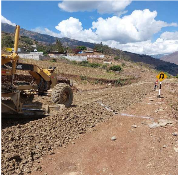
Fotografía 23: Extendido del material de afirmado con la motoniveladora sector ceniza. Prog. 0+045.80 - Prog. 0+071.60
