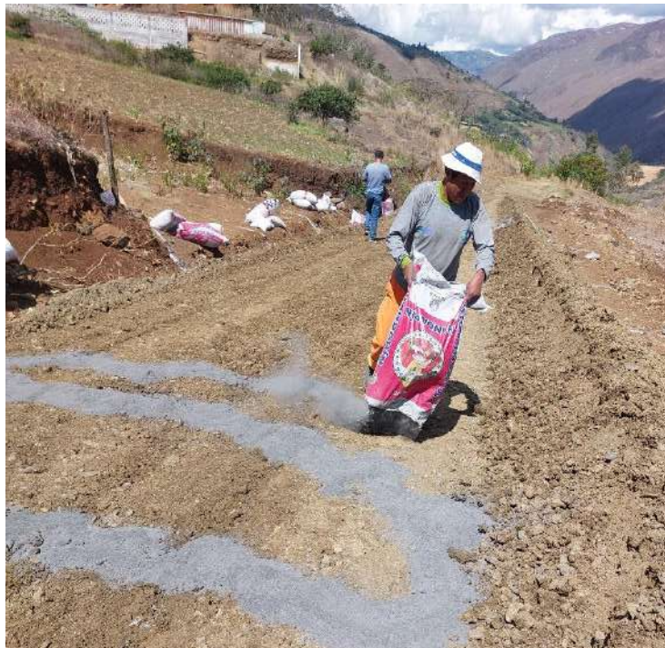
Fotografía 13: Esparcimiento de cal en las secciones. sector ceniza y cal. Prog. 0+076.60 - Prog. 0+90.00
