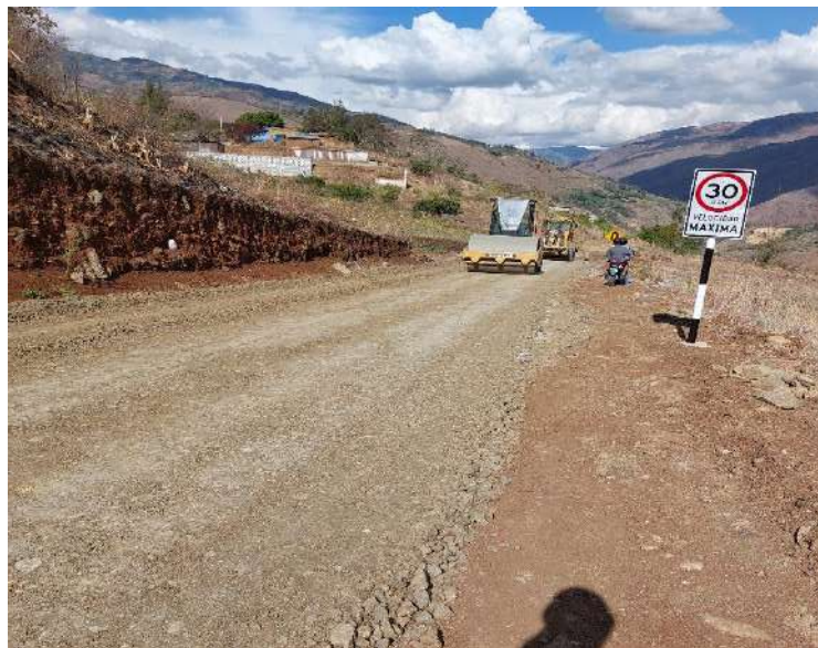
Fotografía 28: Compactación de la capa de afirmado sector ceniza y cal. Prog. 0+090.00 - Prog. 0+102.40
