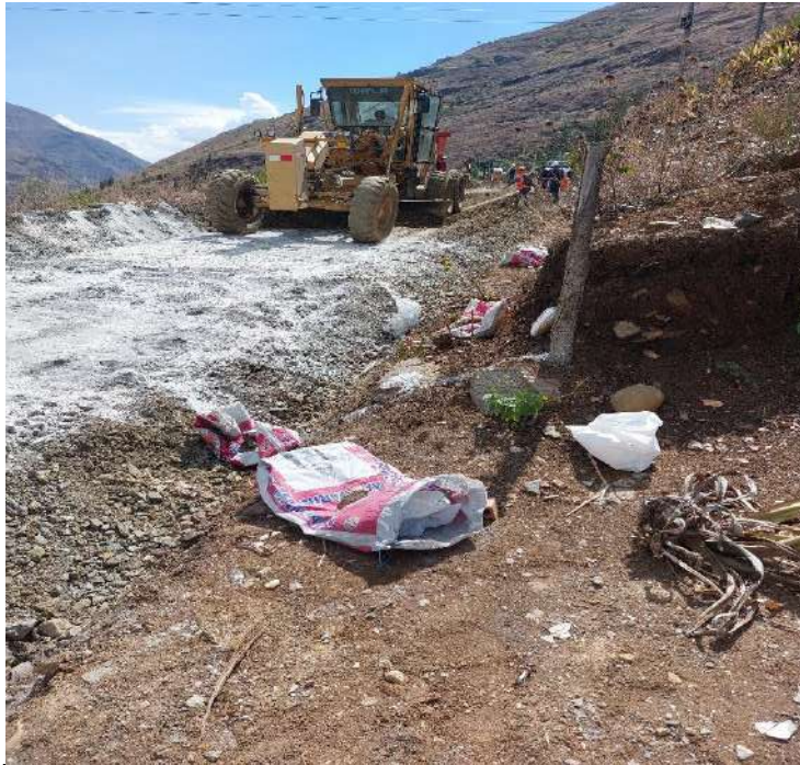
Fotografía 21: Mezclado del material de afirmado, ceniza de bagazo de caña y cal con la motoniveladora sector ceniza y cal. Prog. 0+076.60 - Prog. 0+90.00
