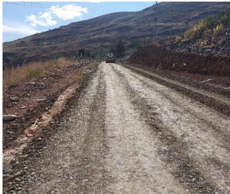
Fotografía 26: Compactación de la capa de afirmado sector ceniza. Prog. 0+030.00 - Prog. 0+040.80
