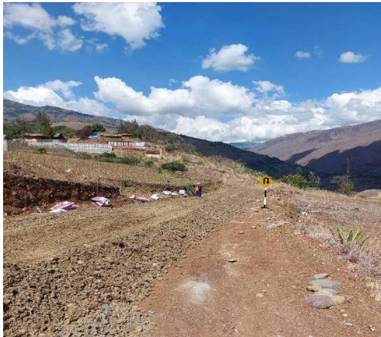
Fotografía 9: Distribución de costales de ceniza y bolsas de cal en las secciones según dosificación Prog. 0+076.60 - Prog. 0+90.00
