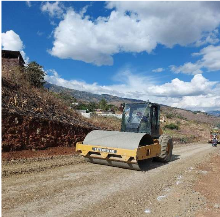
Fotografía 27: Compactación de la capa de afirmado sector ceniza y cal. Prog. 0+076.60 - Prog. 0+90.00
