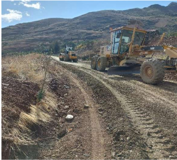
Fotografía 25: Compactación de la capa de afirmado sector ceniza. Prog. 0+015.00 - Prog. 0+030.00
