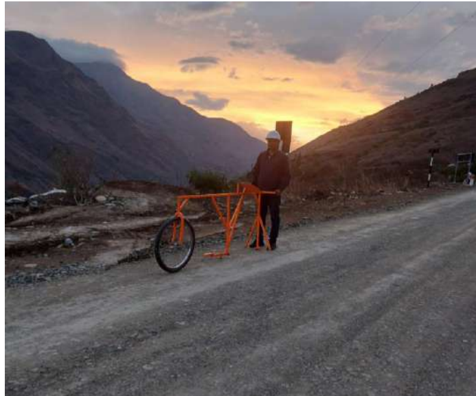
Fotografía 61: Medición de la rugosidad con el equipo merlín Prog, 0+ 076.60 – 0+90.00 (Tramo con afirmado + CBCA + cal)
