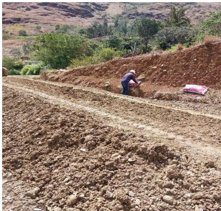
Fotografía 6: costales de ceniza de bagazo de caña preparados para ser esparcidos en las secciones. sector ceniza. Prog. 0+030.00 - Prog. 0+040.80
