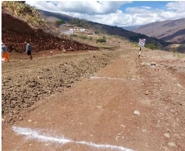
Fotografía 3: Trazo de secciones de 4.725 \times 4.3 m 2 Prog. 0+015.00 - Prog. 0+030.00 , sector ceniza bagazo de caña
