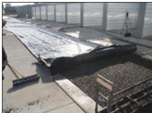
Figura N° 07: Protección del pavimento poroso.
