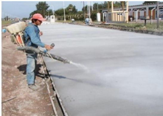
Figura N° 06: Curado del pavimento poroso.
