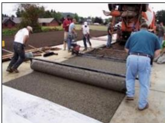
Figura N° 04: Compactación de un concreto poroso.
