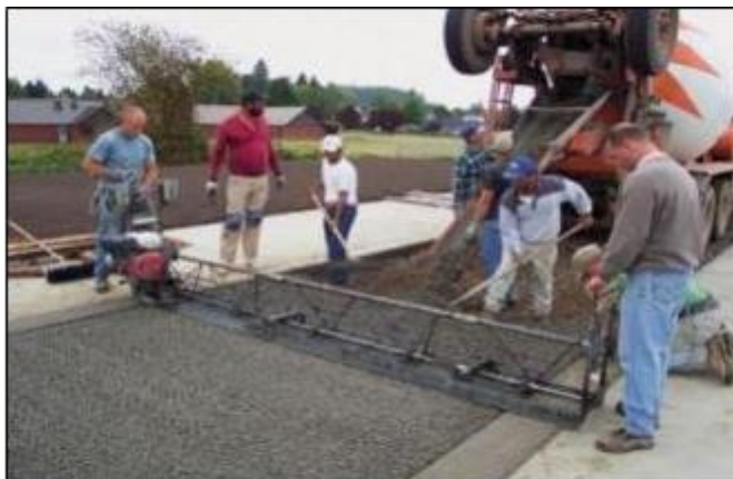
Figura N° 03: Colocado y nivelado del concreto poroso.
