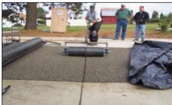
Figura N° 05: Corte de juntas de concreto poroso
