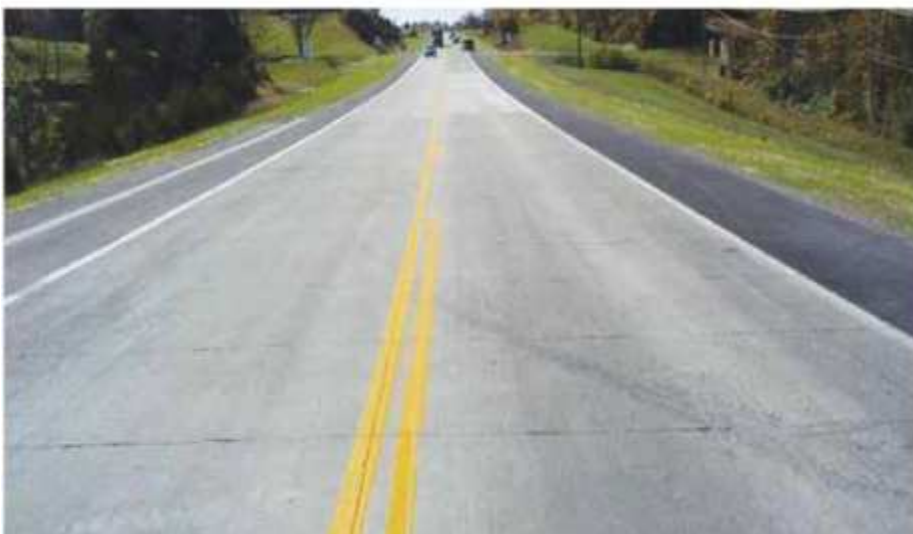
Figura 11 Vía rehabilitada con capa de refuerzo
