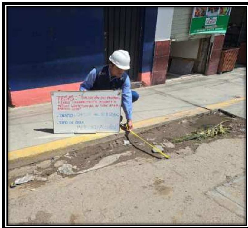
Foto N° 02: Tipo de falla: METEORIZACIÓN en el Km 0+000 al Km 0+250
