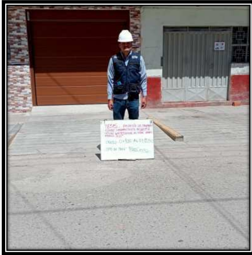
Foto N° 25: Tipo de falla: PARCHEO en el Km 0+1000 al 0+1250
