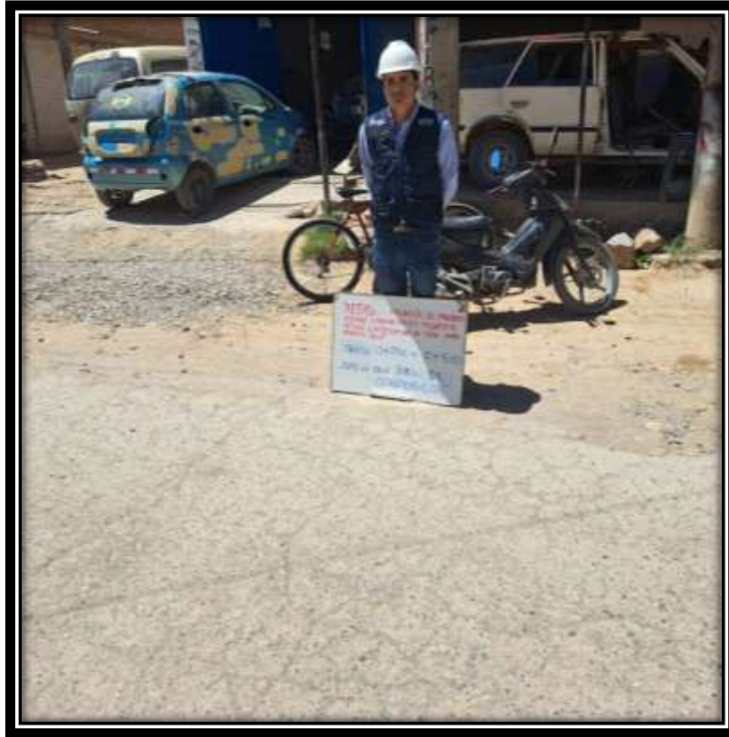
Foto N° 11: Tipo de falla: PIEL DE COCODRILO en el Km 0+250 al 0+500
