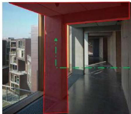
la estructura combina los pórticos con módulos de paneles prefabricados de concreto
