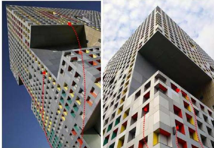
Las columnas y vigas resultantes de estos pequeños cuadrados son lo suficientemente cortas y gruesas para ser estructuralmente bastante rígidas. De esta manera, las esquinas del edificio que cuelgan de las terrazas sustraídas del volumen sin ningún soporte visible, son de hecho voladizos que se sostienen juntos por su piel estructural.
