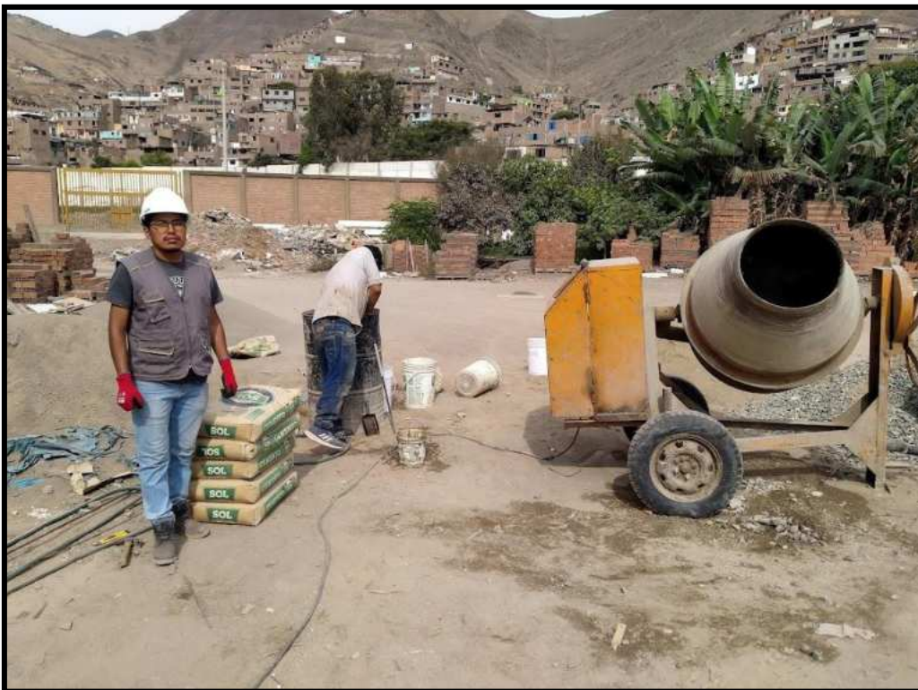
Figura N°23. Inicio de mezcla de materiales para la conformación del concreto.
