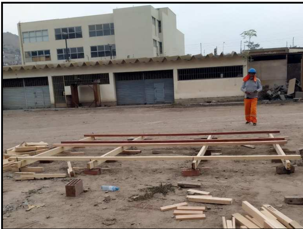
Figura N°09. Encofrado de fondo de losa alig. para Sistema de Prelosa Beton Decken, realizado en exteriores del Laboratorio de Estructuras CISMID-UNI.
