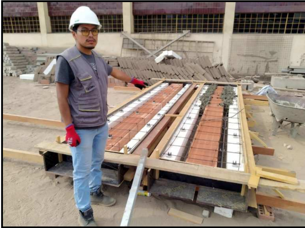
Figura N°24. Inicio del Vaciado del concreto F'c=210\text{kg/cm}^2 en las SCLA01 y SCLA02
