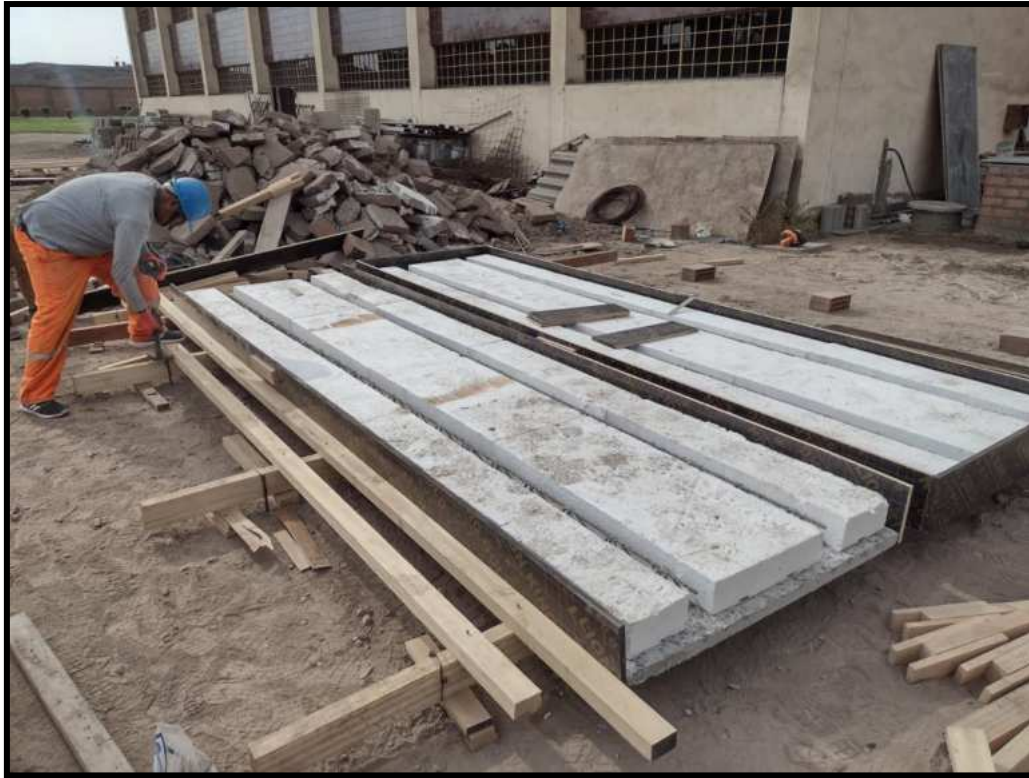
Figura N°12. Encofrado lateral en prototipos SPBD01 y SPBD02
