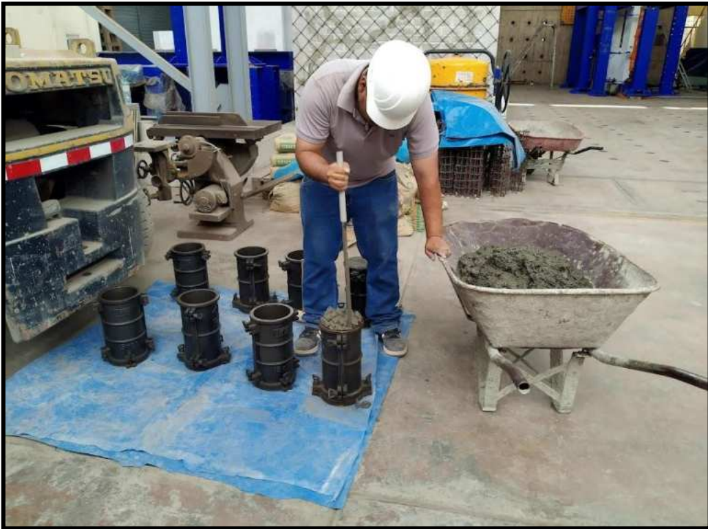
Figura N°21. Se aprecia el vertido del concreto en su capa final para la conformación de probetas y su validación de la resistencia a la compresión.
