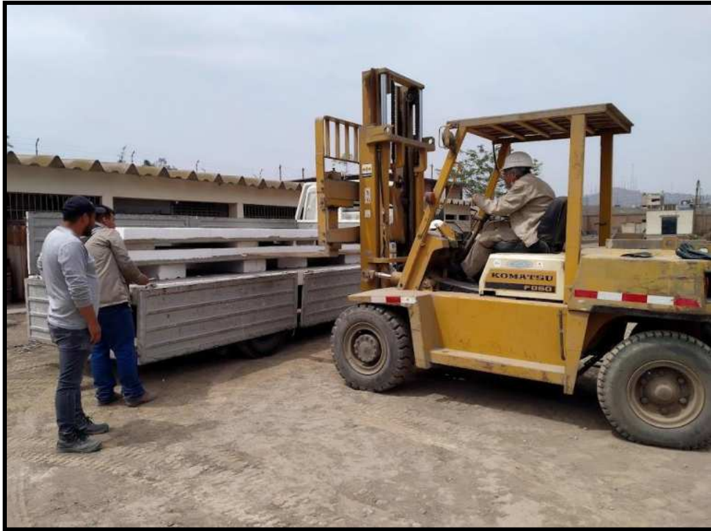
Figura N°10. Llegada de prototipos BD hacia CISMID-UNI para su transporte mediante montacarga.
