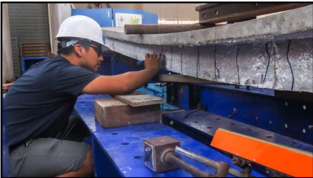
Figura N°41. Espécimen: SCLA01 – Marcas de fisuramiento durante el ensayo a la flexión en la cara lateral derecha
