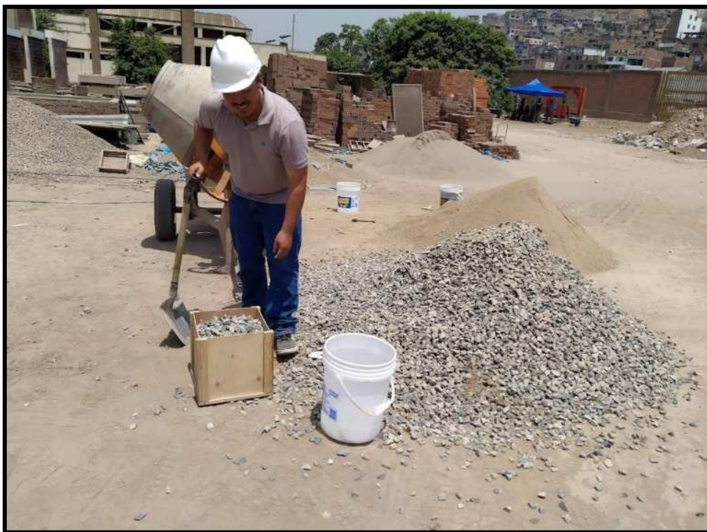
Figura N°17. Cubicación de piedra chancada para la proporción en piedra chancada de acuerdo al diseño de mezcla.
