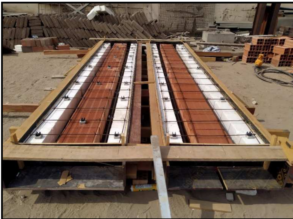
Figura N°13. Encofrado de la Losa Aligerada SCLA01 y SCLA02.
