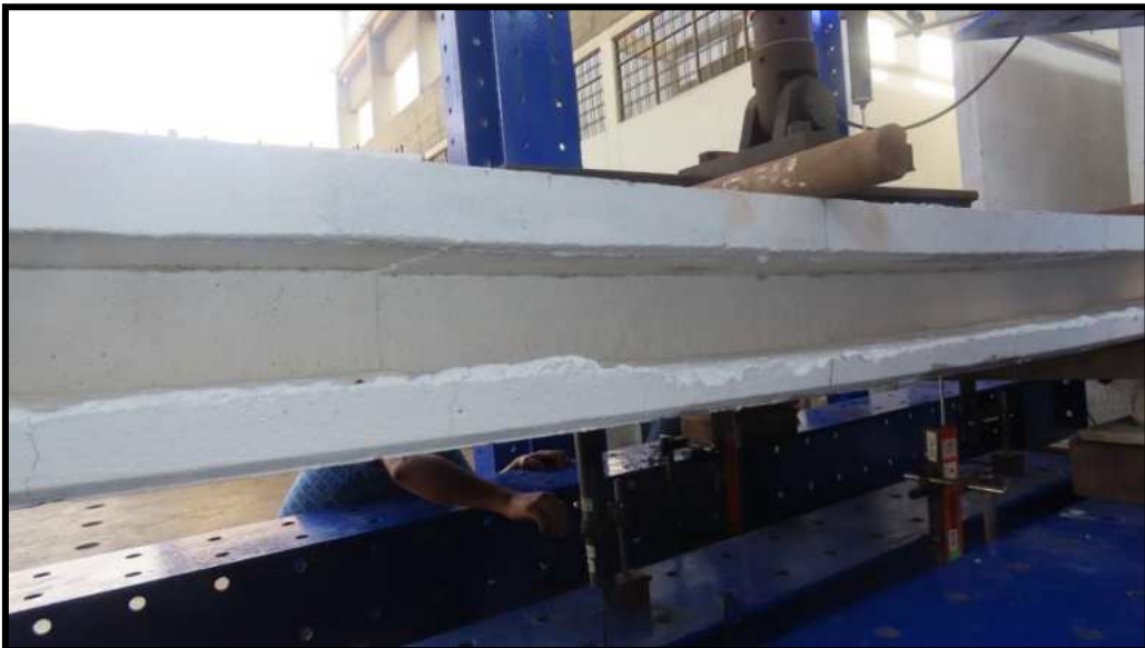
Figura N°55. Espécimen: SPBD02 – Inicio de deformaciones y agrietamiento en el alma de la viga I.
