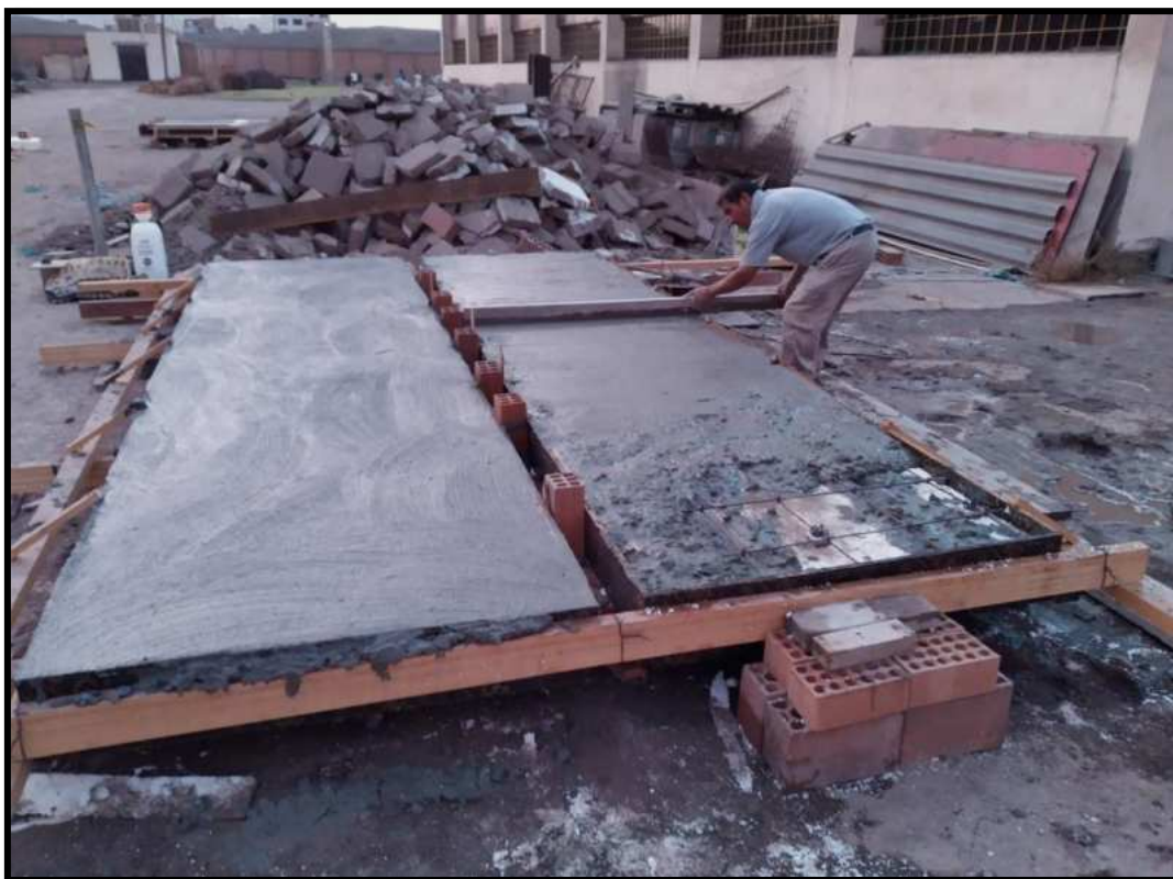
Figura N°29. Culminación del vaciado de concreto F'c=210\text{kg/cm}^2 SCBD.
