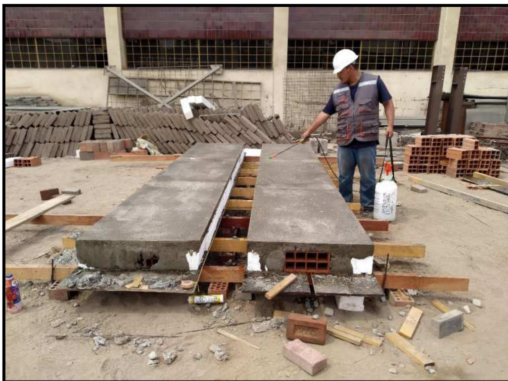
Figura N°30. Proceso de curado con Sika Cem sobre el SCLA.
