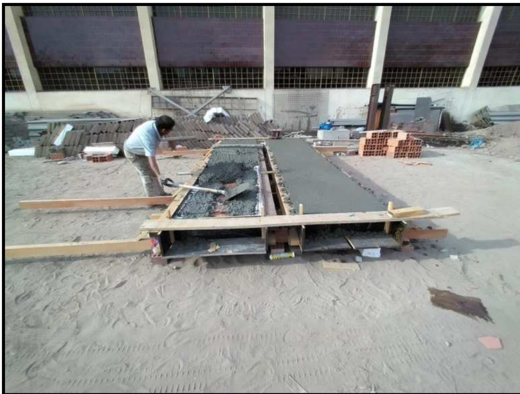
Figura N°27. Culminación del Vaciado del concreto F'c=210\text{kg/cm}^2 en las SCLA01 y SCLA02
