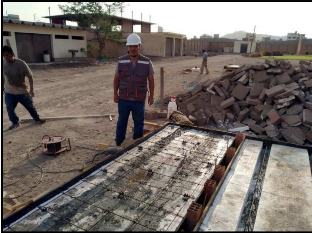
Figura N°28. Inicio del Vaciado del concreto F'c=210\text{kg/cm}^2 en las SPBD01 y SPBD02.
