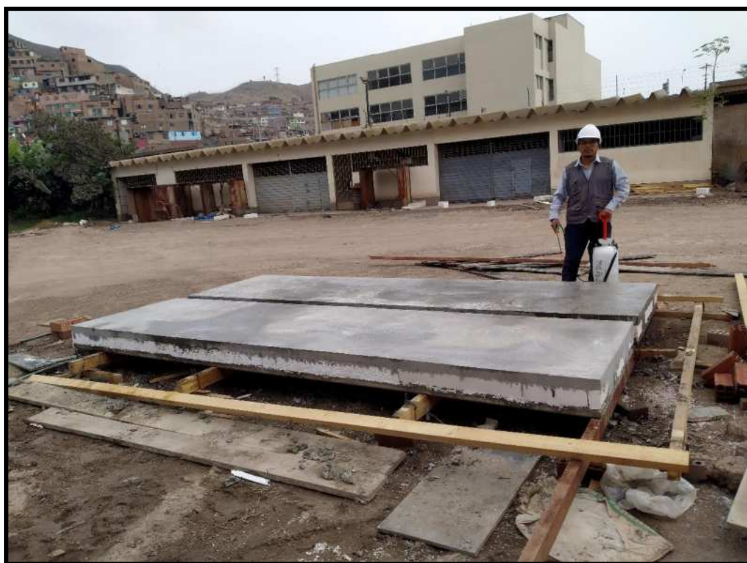
Figura N°31. Proceso de Curado con Sika Cem sobre los prototipos de SPBD.
