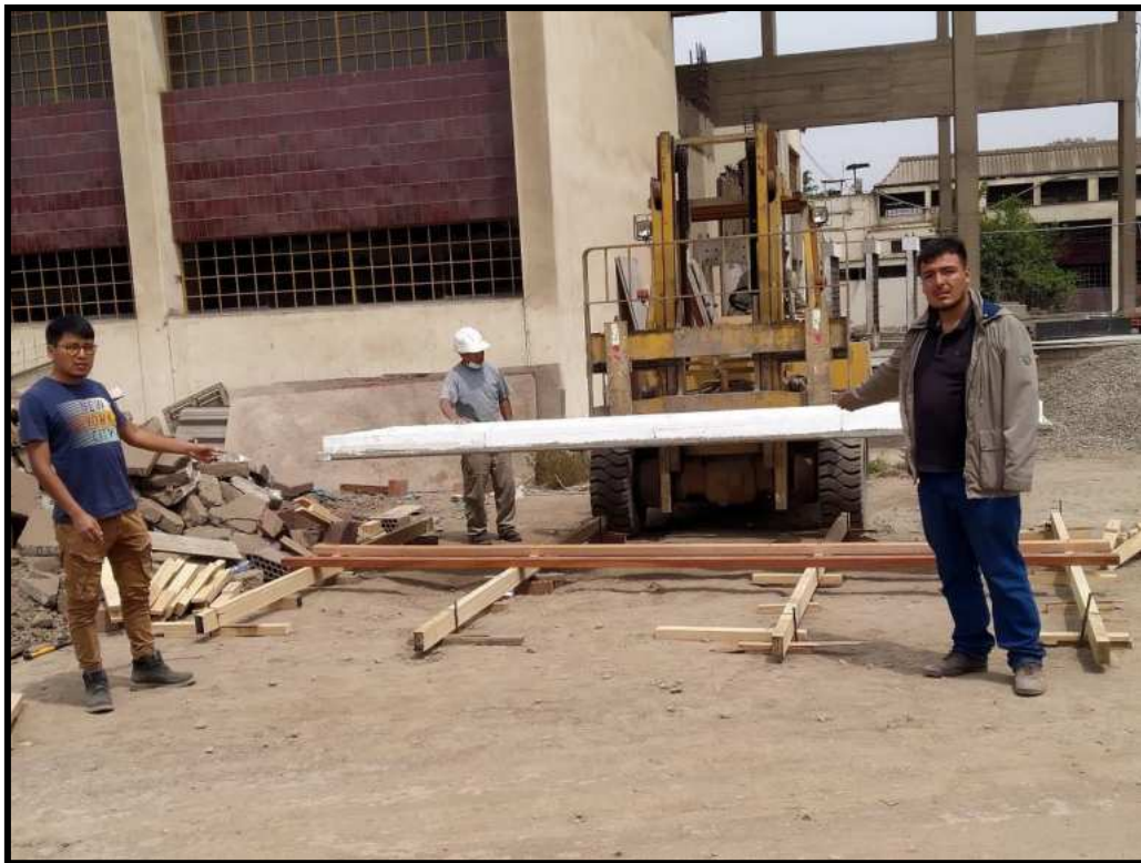
Figura N°11. Colocación del Sistema de Prelosas Beton Decken sobre el encofrado.
