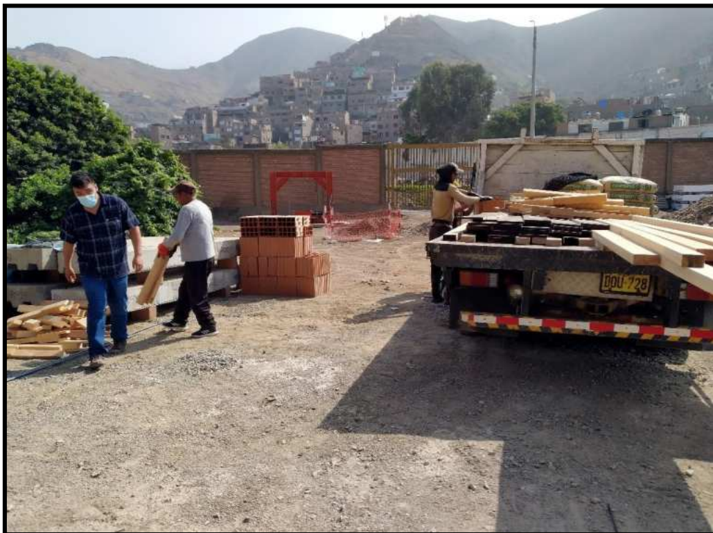
Figura N°07: Transporte de materiales al laboratorio del CISMID-UNI para el encofrado.
