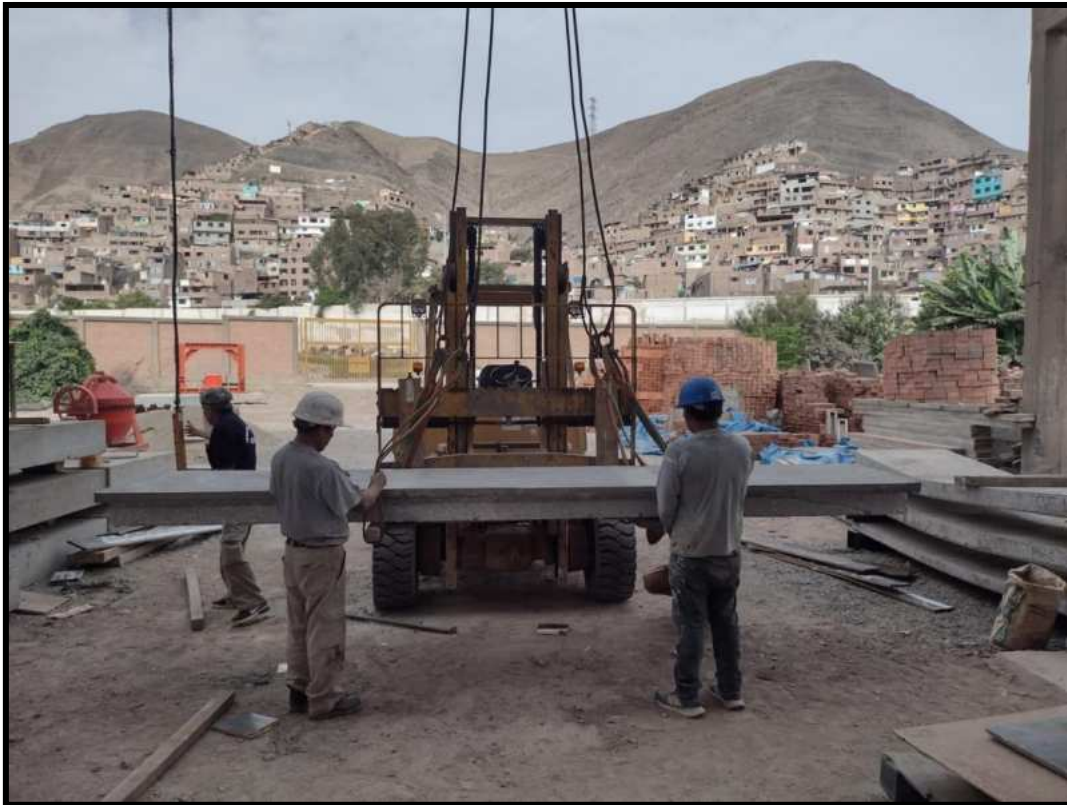
Figura N°36. Traslado con tecla del laboratorio de los prototipos de SCLA.
