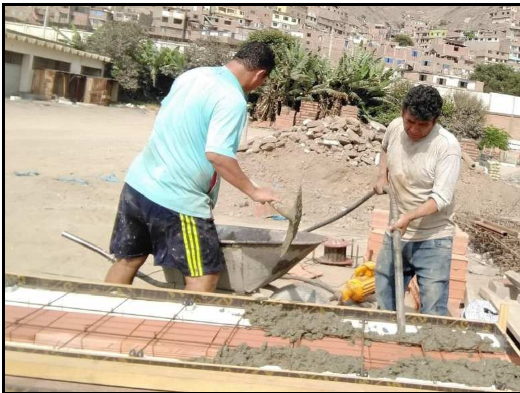
Figura N°25. Procedimiento del vibrado la zona de viguetas de concreto.
