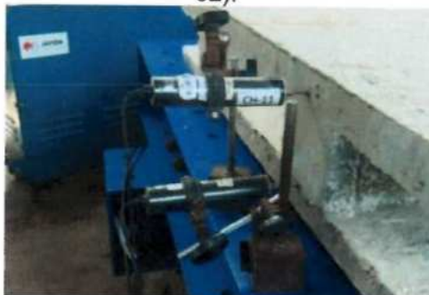
Foto 3. Transductores laterales cara Norte (CH-07 y CH-08).
