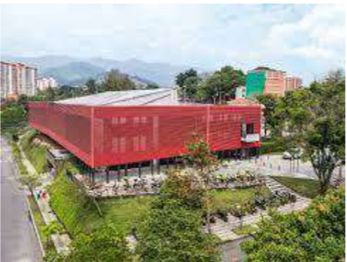
Vista exterior – Estación policial de Belén
