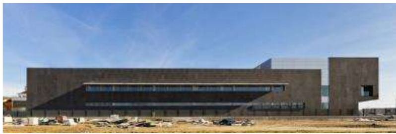
Figura 33 Fachada longitudinal – Comisaría Lugo
