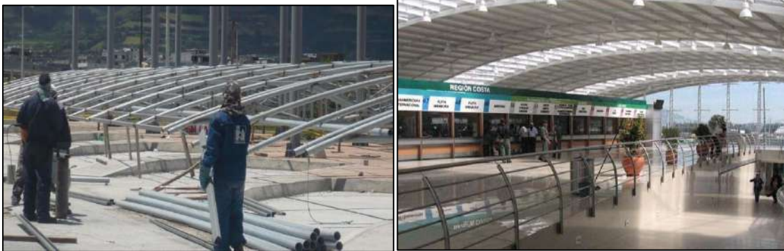
Figura 53 Estructura de la cubierta
