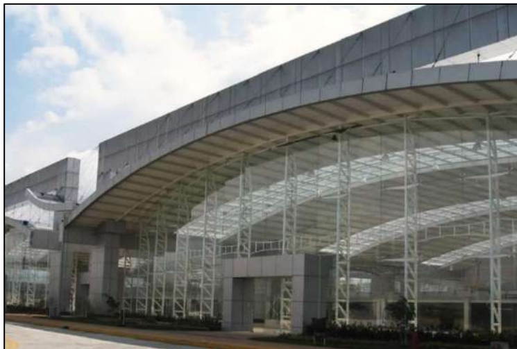
Figura 54 Sistema estructural de la fachada
