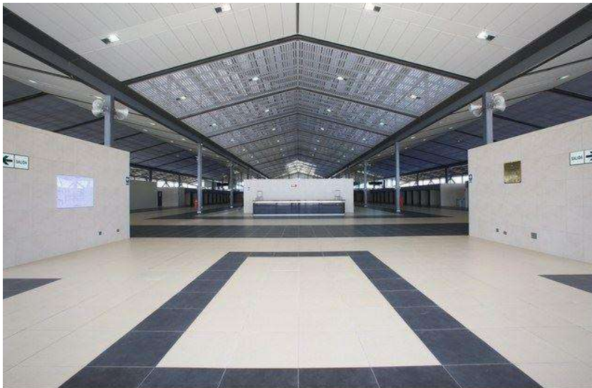
Figura 62 Coberturas con pendientes al interior del terminal
