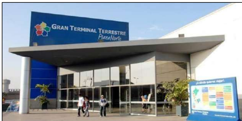
Figura 25 Gran Terminal Terrestre Plaza Norte Lima
