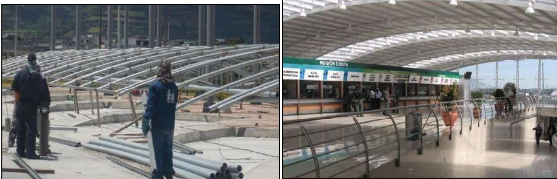
Figura 53 Estructura de la cubierta
