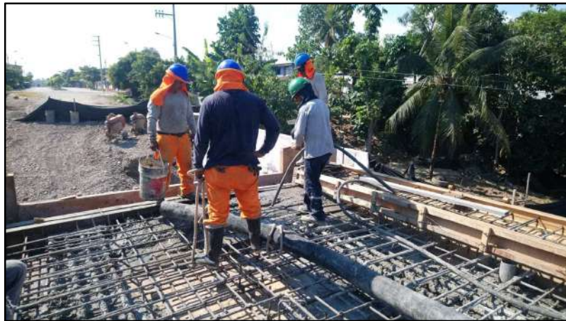
Fotografía 22.- Colocación de concreto en la superestructura
