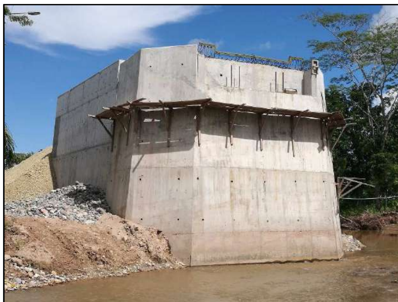
Fotografía 18.- Edificación del estribo izquierdo
