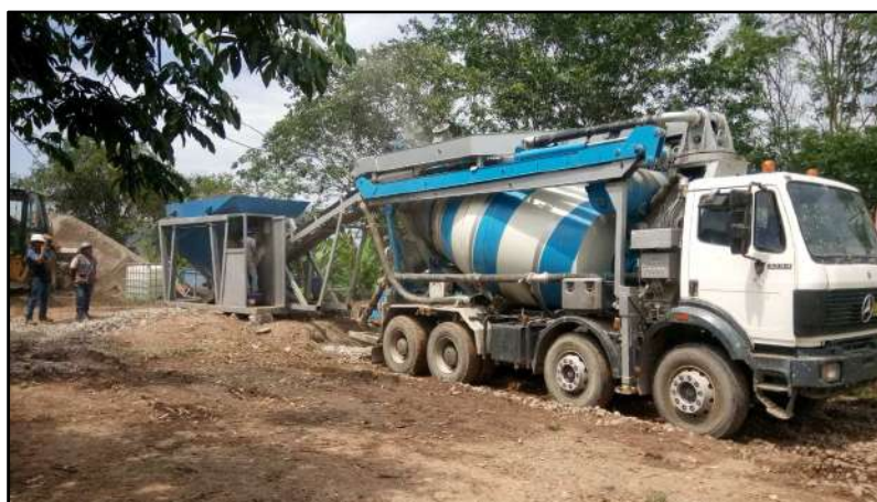
Fotografía 13.- Planta de producción de concreto
