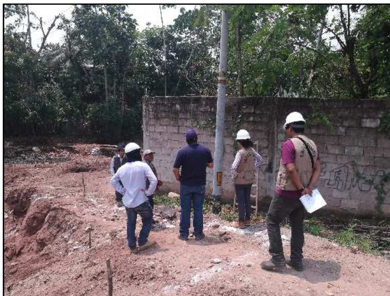
Fotografía 2.- Trabajos de replanteo
