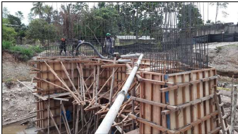
Fotografía 15.- Colocación de concreto en pantalla y aletas de estribo
