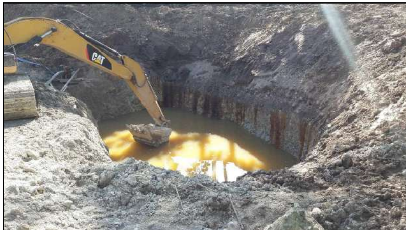
Fotografía 6.- Excavación bajo agua para la cimentación de estribos
