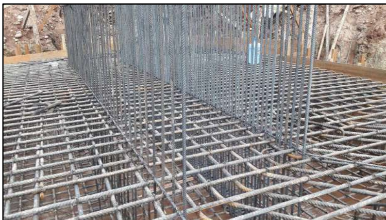
Fotografía 11.- Colocación de acero en la zapata y pantalla de estribos y aletas
