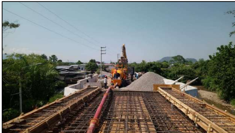
Fotografía 21.- Planta de producción de concreto
