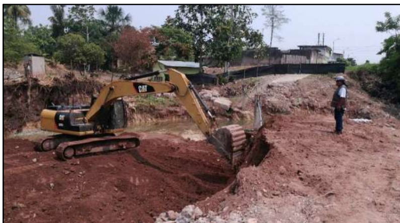
Fotografía 4.- Excavación de zanjas con maquinaria para la cimentación de estribos
