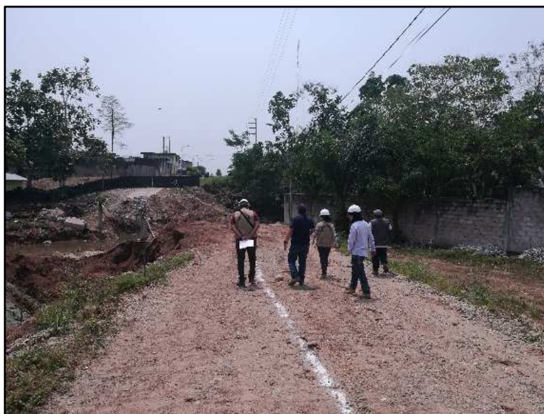
Fotografía 1.- Trabajos de replanteo
