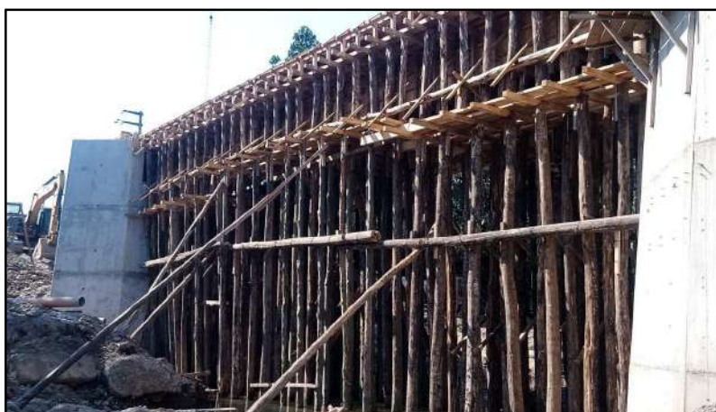
Fotografía 19.- Construcción de falso puente
