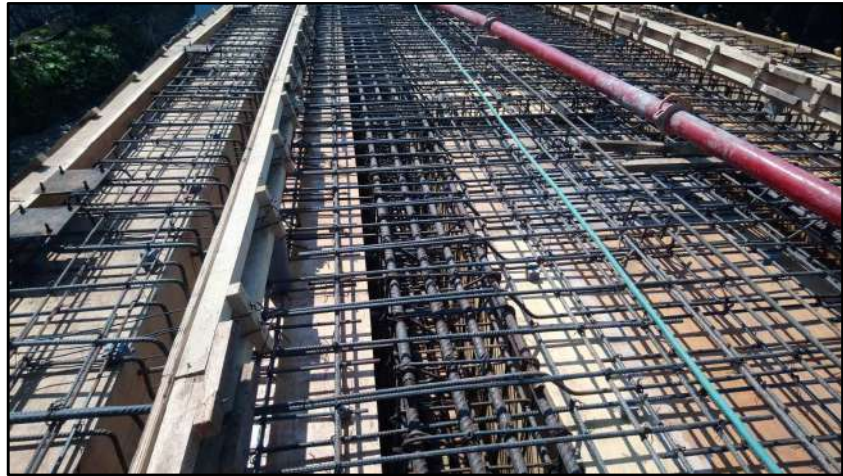
Fotografía 20.- Acero de la superestructura
