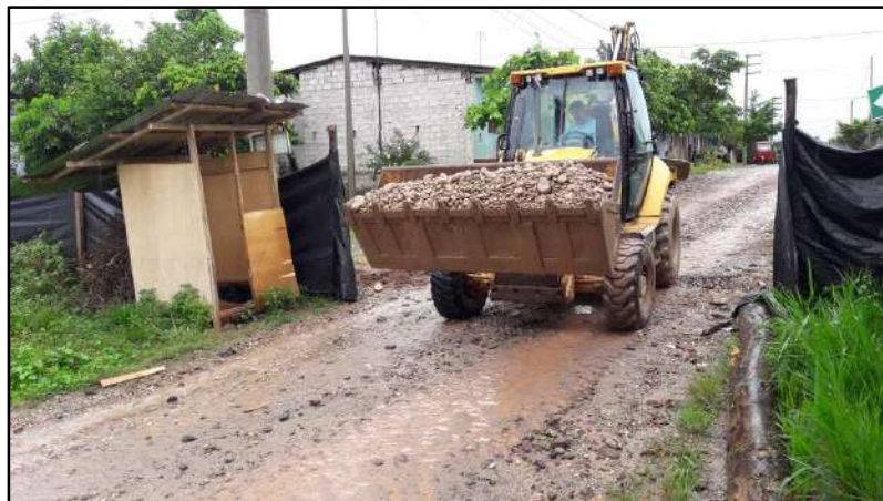
Fotografía 7.- Transporte de material para relleno
