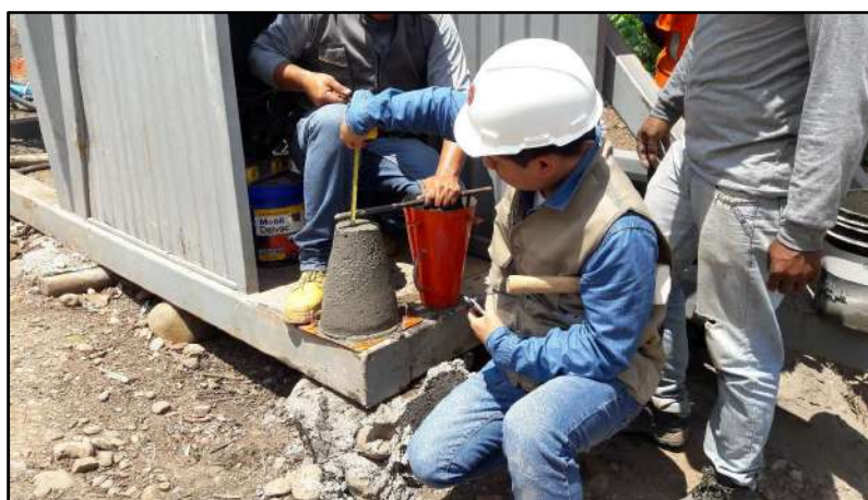
Fotografía 16.- Verificación del Slump, para el control de la plasticidad del concreto
