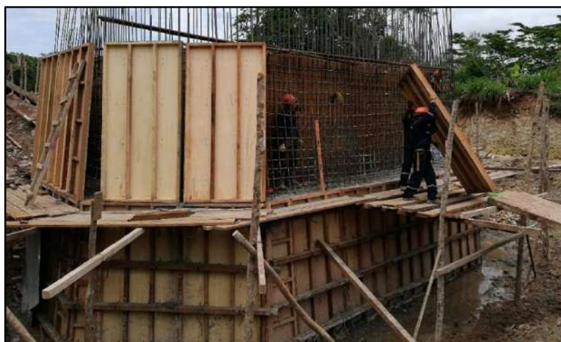
Fotografía 10.- Encofrado de pantalla y aletas de estribo
