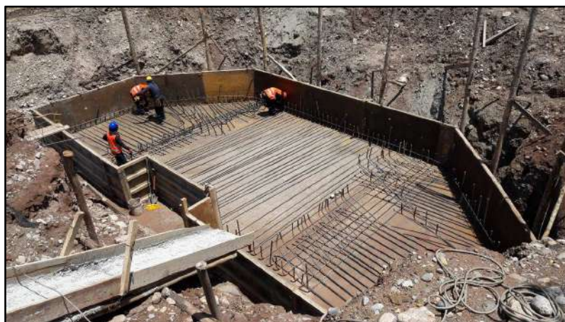
Fotografía 9.- Encofrado de zapata de estribo
