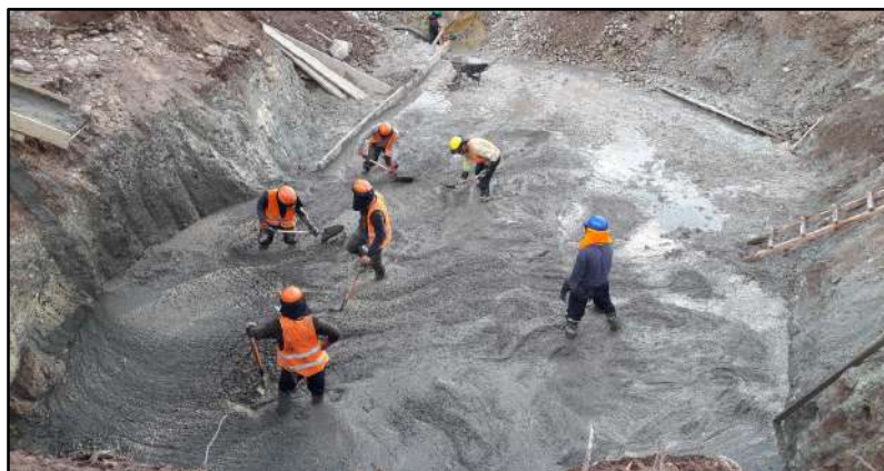
Fotografía 8.- Construcción de solado para la cimentación de estribos
