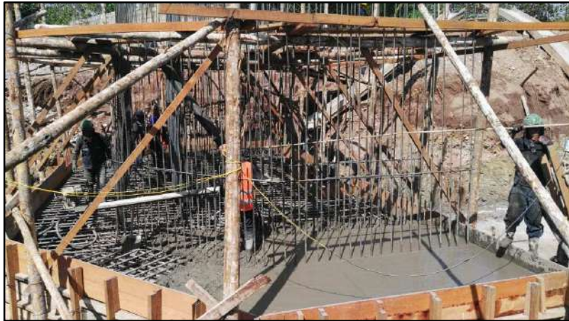
Fotografía 14.- Colocación de concreto en zapata de estribo
