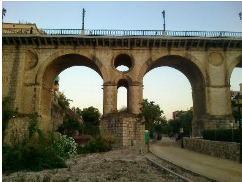
Figura 6 Puente de mampostería
