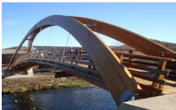
Figura 5 Puente de madera
