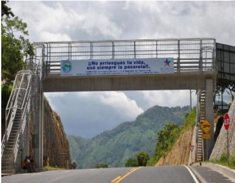
Figura 4 Puente de Concreto Armado
