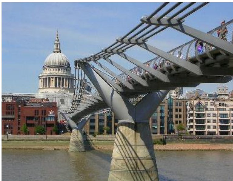
Figura 7 Puente de acero
