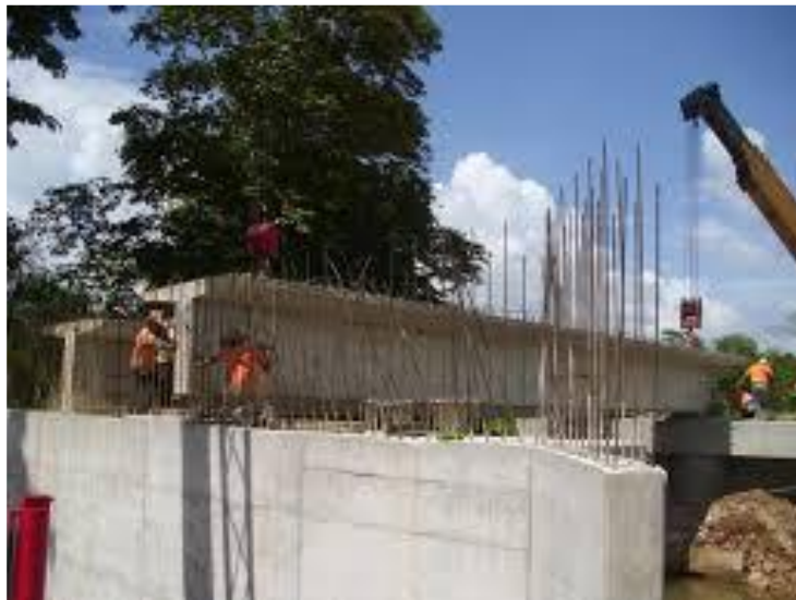
Figura 9 Puente concreto preesforzado
