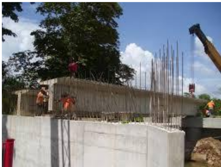
Figura 9 Puente concreto preesforzado
