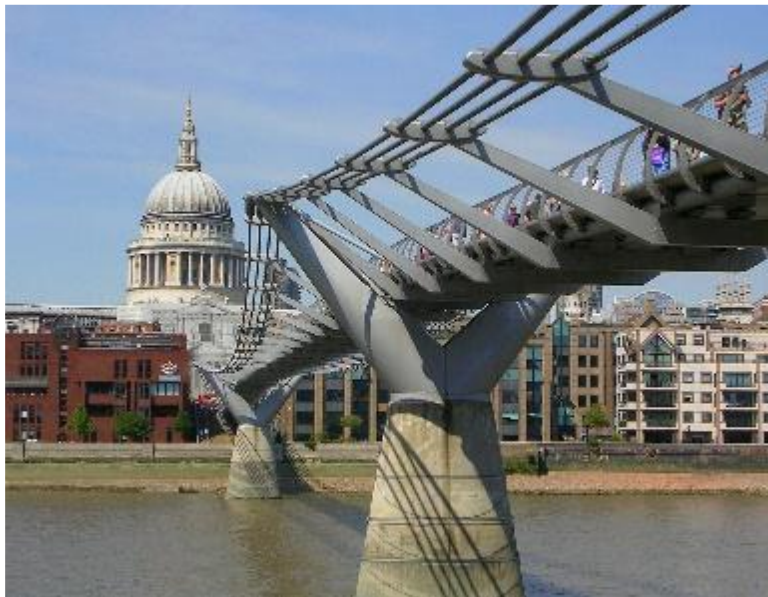
Figura 7 Puente de acero
