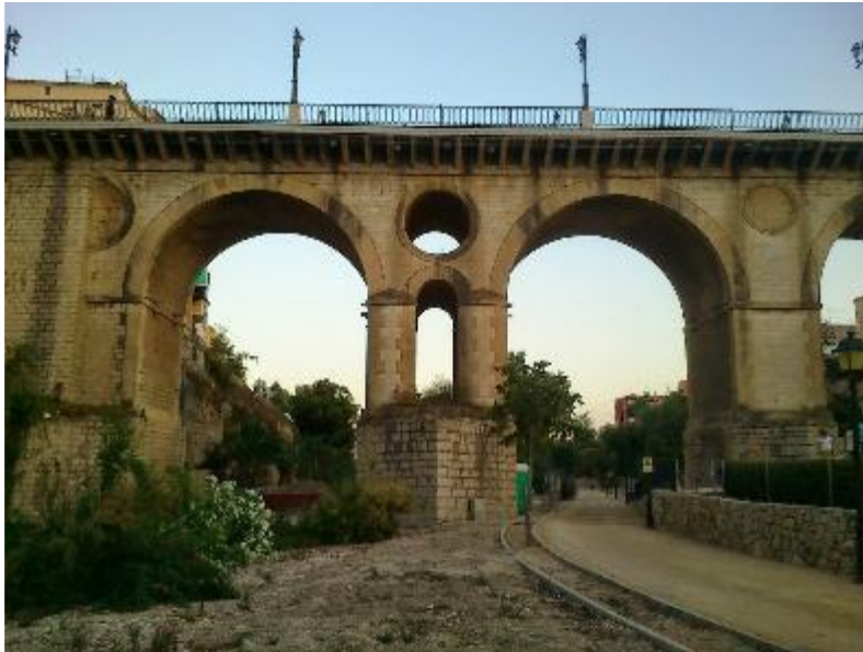
Figura 6 Puente de mampostería
