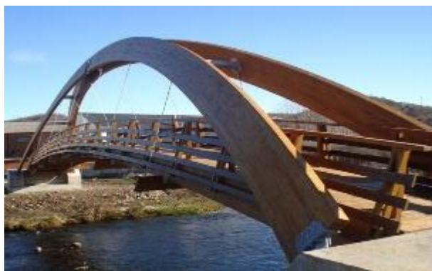
Figura 5 Puente de madera
