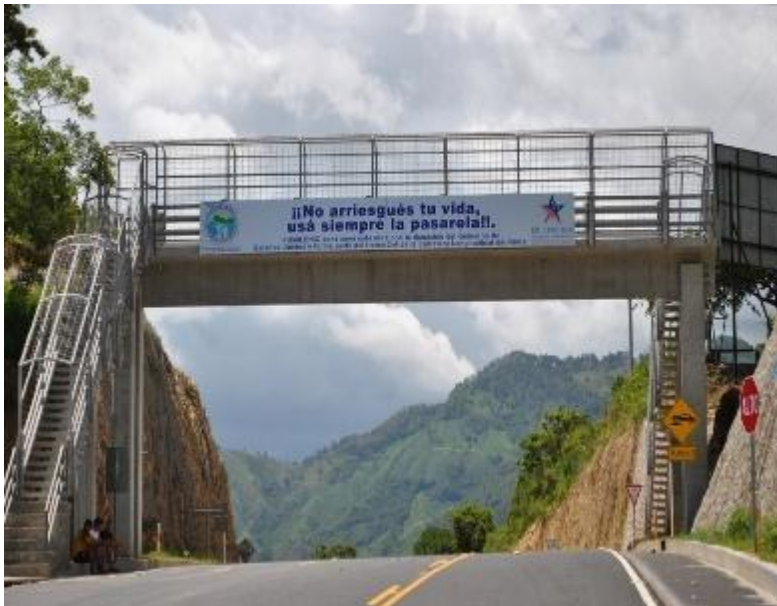
Figura 4 Puente de Concreto Armado
