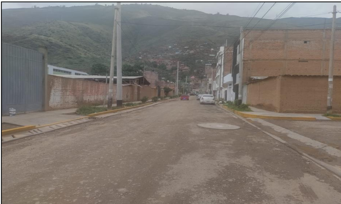
Imagen 1: Jr. Bella Durmiente tramo 1
