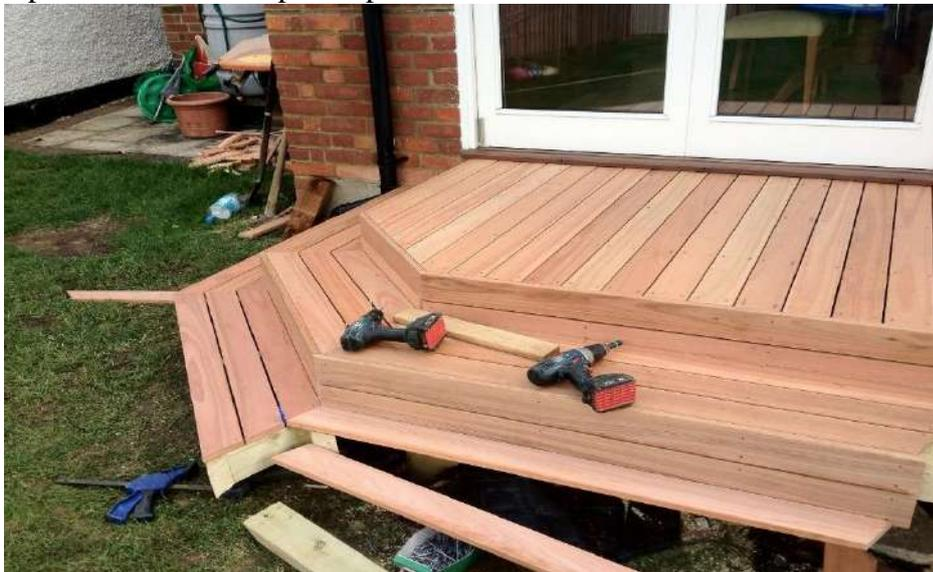
Nota: En la imagen se visualiza la aplicación de la madera eucalipto en pisos. Fuente: Tesis eucalipto la madera del futuro Cadamda (2019).
