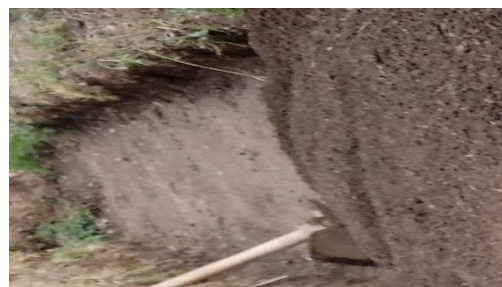
Foto N°16 Construcción de cama de repique
