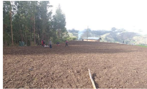
Foto N°28 Nivelación del terreno.
