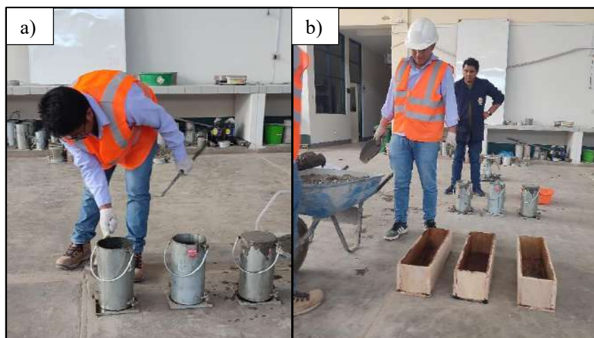
Figura 41 Moldes para probetas de ensayos
