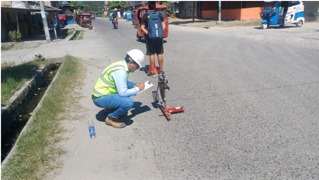
Nota: Toma lectura del pavimento
