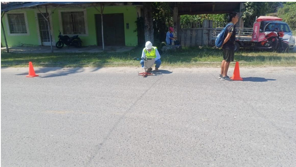
Nota: Toma lectura del pavimento
