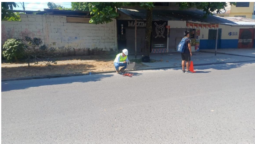
Nota: Toma lectura del pavimento
