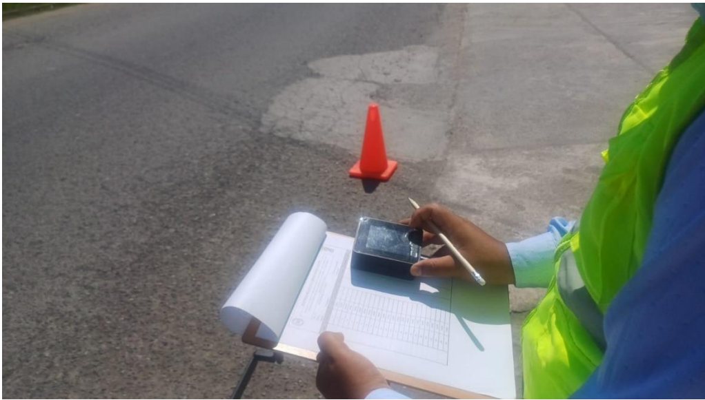
Nota: Toma lectura del pavimento
