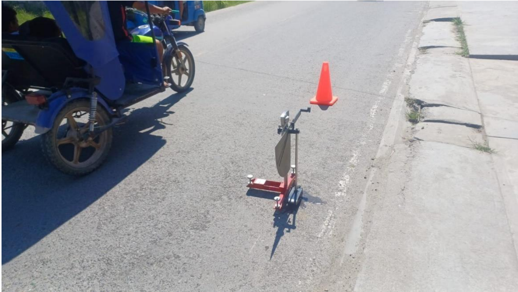
Nota: Toma lectura del pavimento
