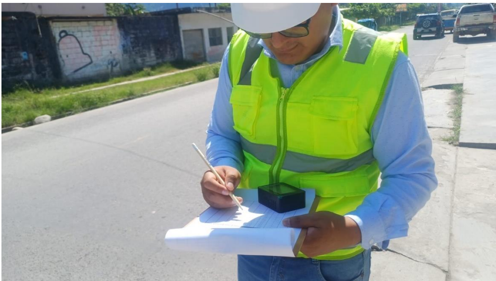
Nota: Toma lectura del pavimento
