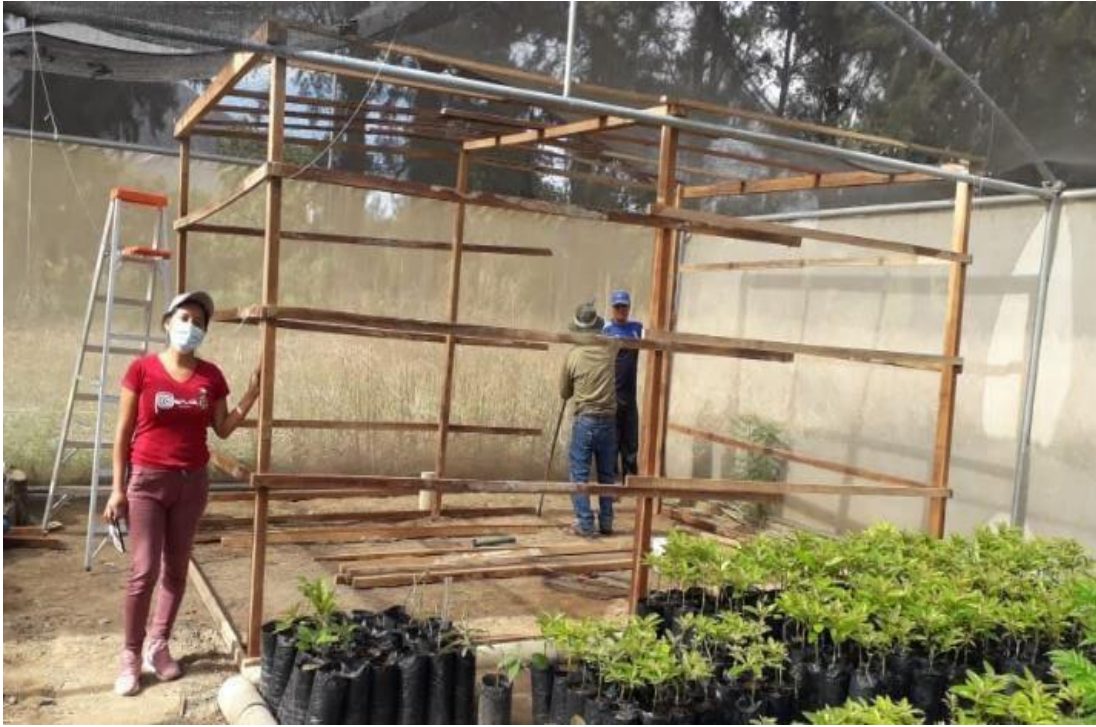
Foto 11. Construcción de cámara de etiolación
