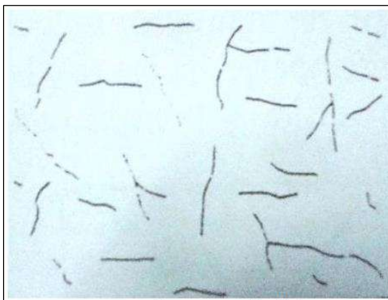
Fotografía 2.2 Fisura por tracción plástica muy amplias
