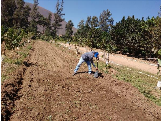
Imagen 01. Nivelación del terreno
