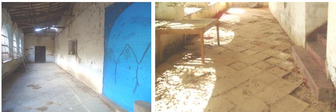
Imágenes 135, 136: Los muros originales poseen revoque de torta de barro con material vegetal y acabado con lechada de cal.
