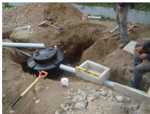
Imagen N° 25: Funcionamiento de Biodigestor. Fuente: Conferencia Gobierno Regional Huánuco: Sánchez L. Eternit
