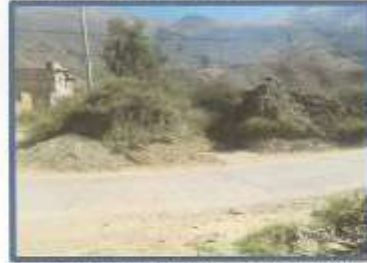
La carretera Huánuco – Conchumayo presenta badenes por donde discurre aguas pluviales (Imagen 18)
