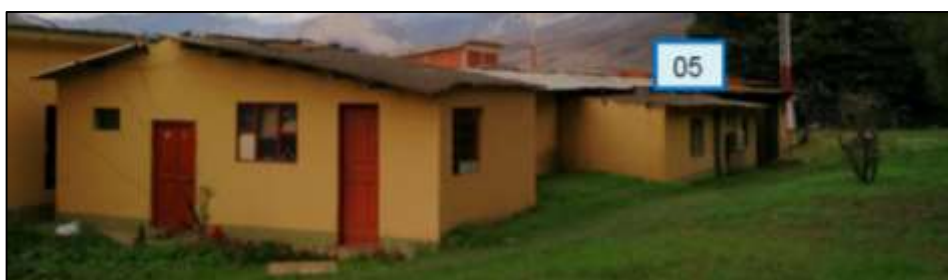
Imagen N° 22: Oficina del personal de seguridad; Arq. Marroquín; pág. 8
