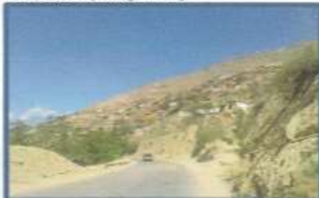
En dirección a la zona de a evaluar se aprecia asentamientos que presentan un nivel de riesgo Muy Alto. (Imagen 05)
