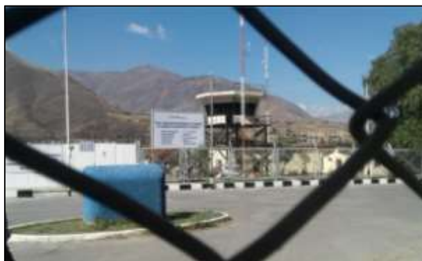
Imagen N° 27 Cartel de obra; fuente: toma fotográfica propia
