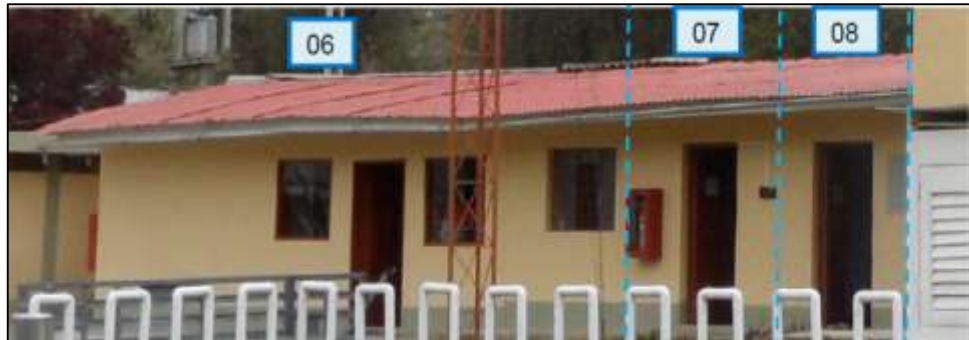
Imagen N° 23: Área de oficinas; Arq. Marroquín; pág. 9
