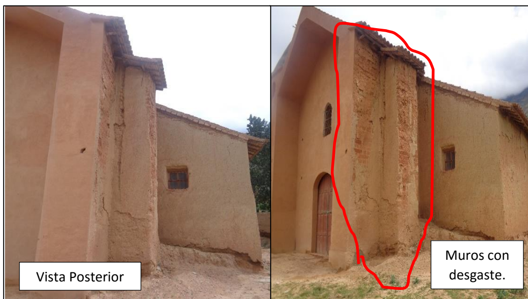
Ilustración 58: Muros sin resanar, con desgaste de la franja superior e inferior.
