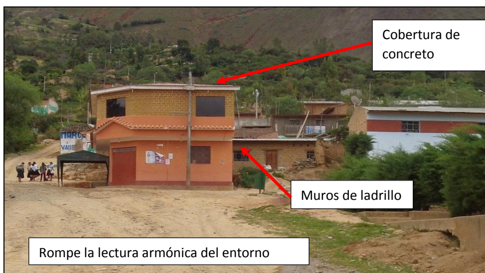
Ilustración 17: Viviendas construidas en Material Noble
