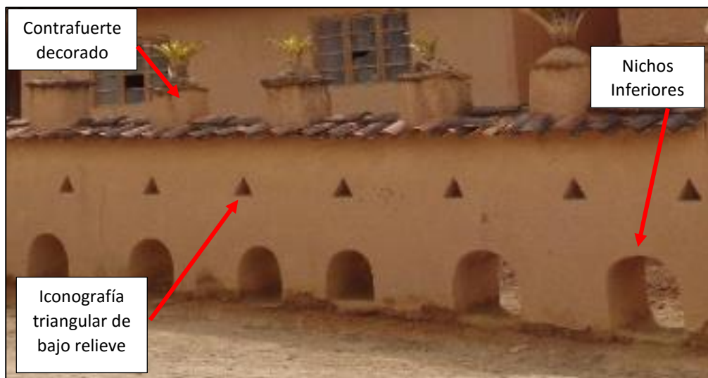
Ilustración 63: Vista en Perfil del Muro Pretil
