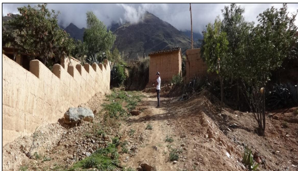
Ilustración 6: Vista del Jr. Bolívar – Pendiente del tipo colinado.
