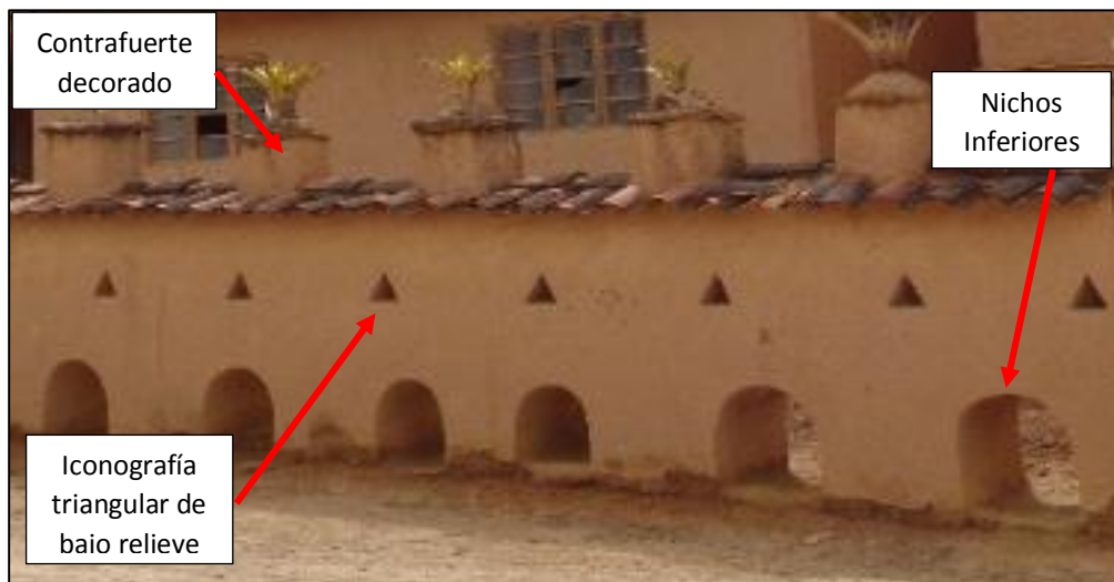
Ilustración 36: Vista del Muro Pretil
