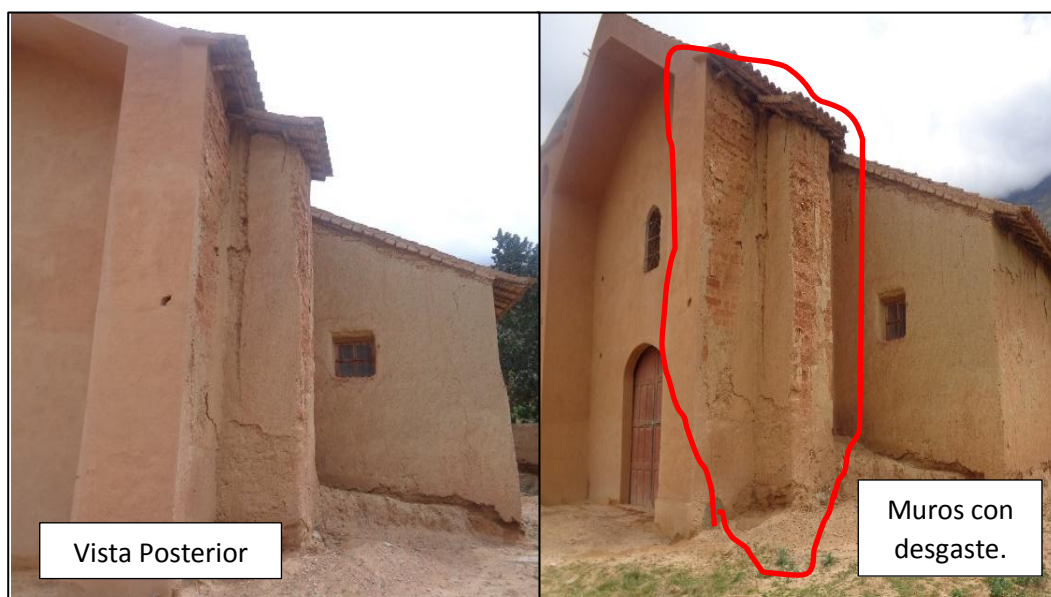
Ilustración 31: Muros sin resanar, con desgaste de la franja superior e inferior.
