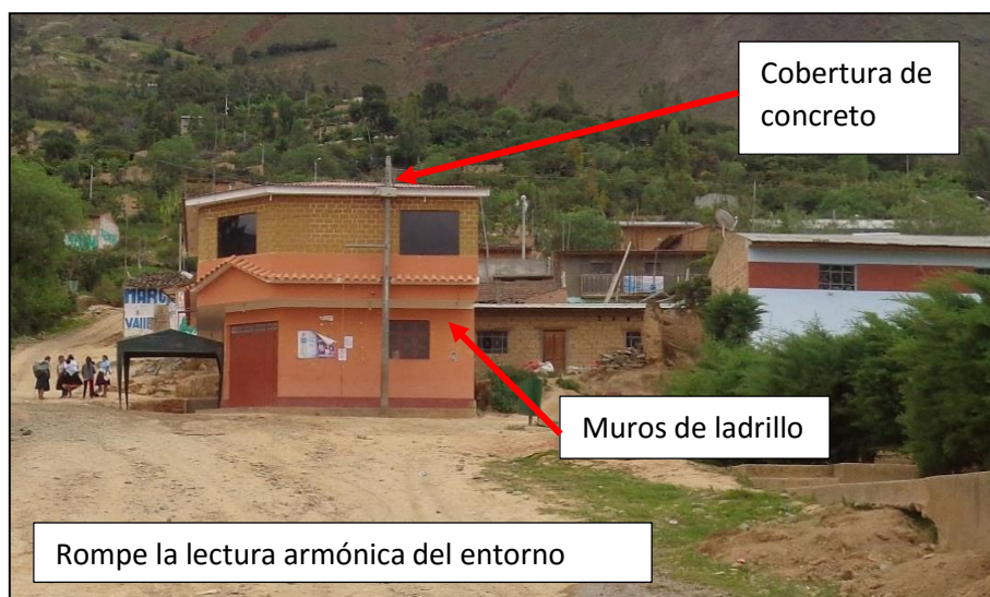
Ilustración 17: Viviendas construidas en Material Noble
