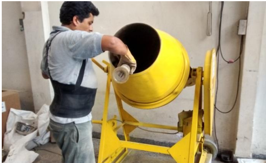
Figura 2.3. Adicionando el agua para la elaboración del concreto.
