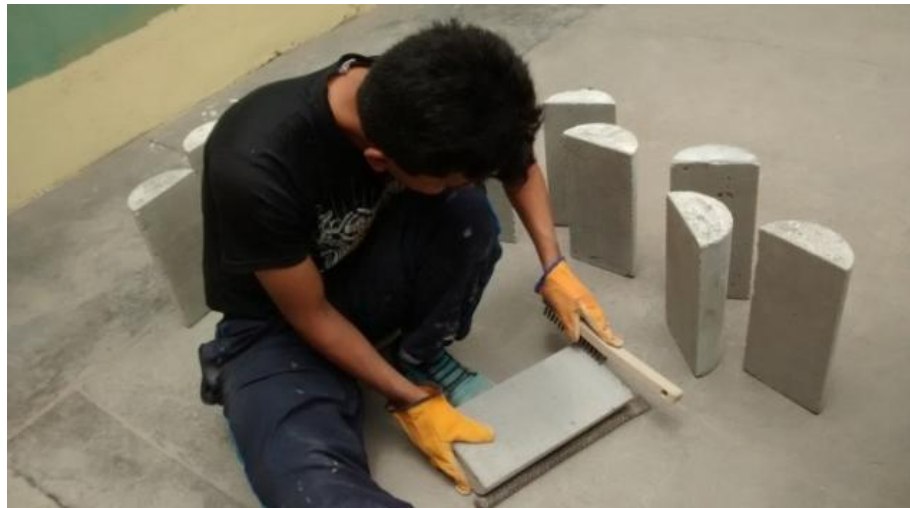
Figura 2.12. Limpieza con escobilla de acero de la lechada de cemento.
