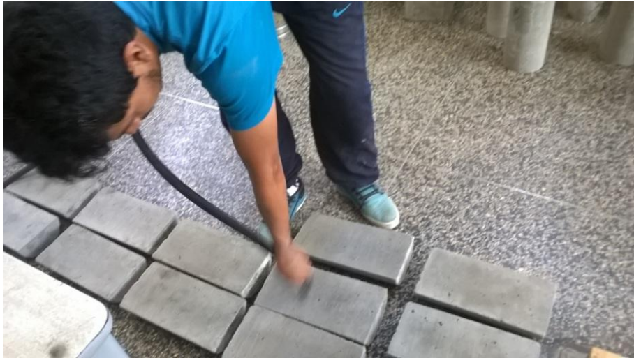
Figura 2.13. Limpieza con aire comprimido.
