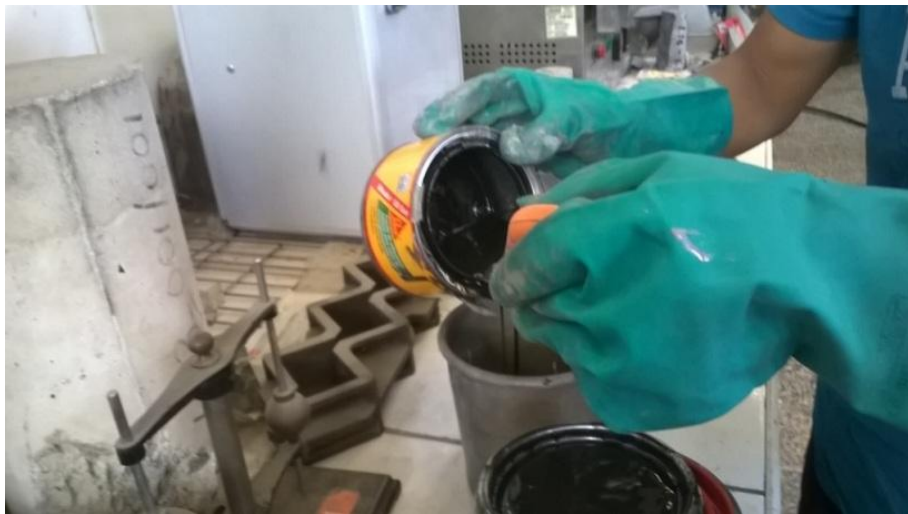
Figura 2.14. Preparación del adhesivo epóxico (Sikadur-32 gel) para el pegado de concreto viejo y nuevo.
