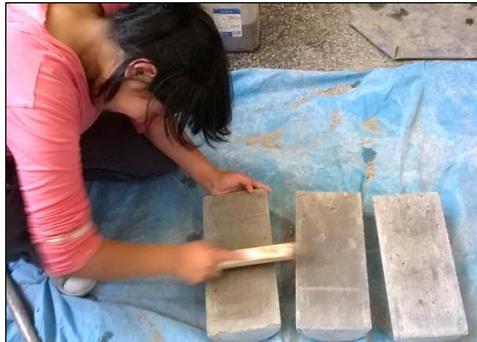
Figura 2.21 – Tratamiento sin adhesivo o escobillado de superficie de contacto FUENTE: Elaboración propia
