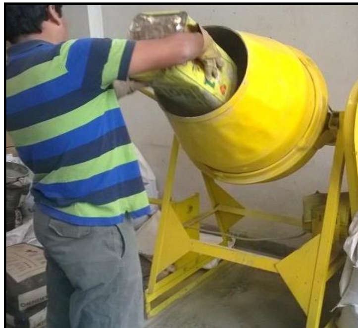
Figura 2.6 – Elaboración de la mezcla del concreto
