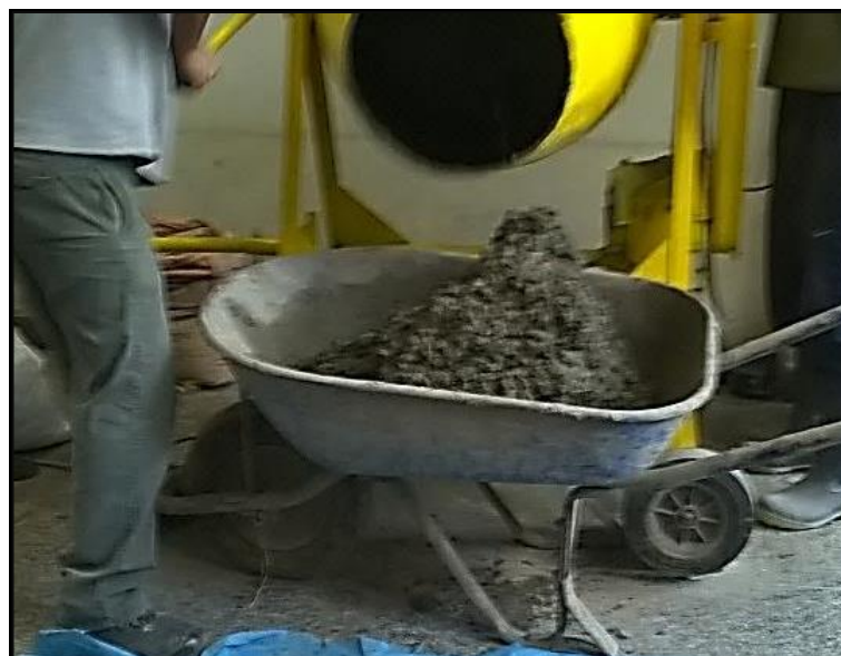
Figura 2.7 – Recepción de mezcla del concreto
