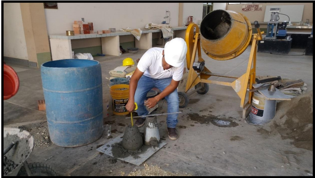
Fig. 30: En la vista se muestra la verificación del slump del concreto el cual fue se asume en el diseño de mezclas y debe de cumplirnos.
