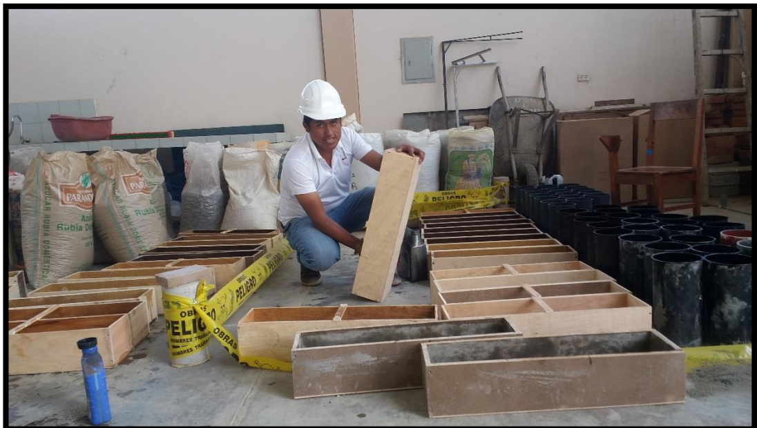
Fig. 27: En la vista se muestra el habilitado de los moldes en el cual se realizó la limpieza de toda la superficie antes de realizar el colocado del concreto
