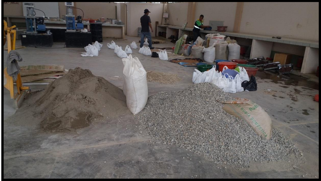
Fig. 26: En la vista se muestra el agregado a utilizarse en el vaciado de vigas y probetas cilíndricas
