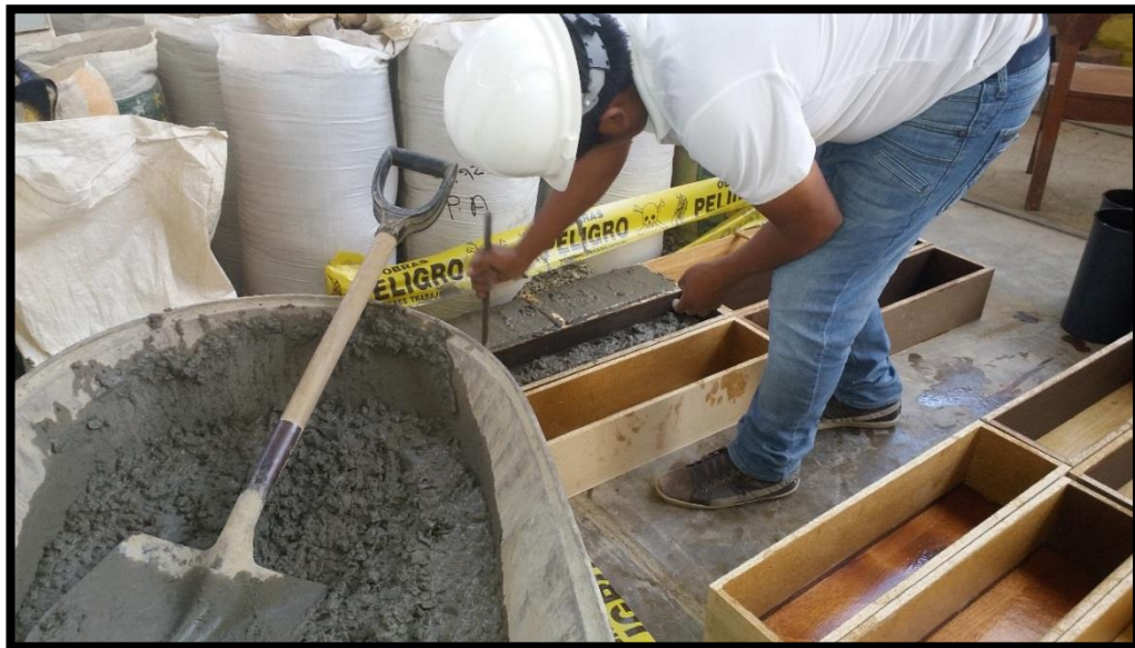
Fig. 16: Llenado de concreto en los moldes de vigas de madera.
