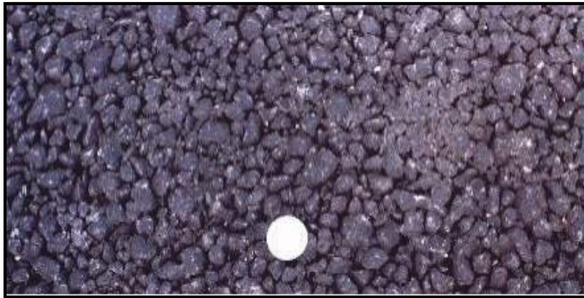
Figura N° 6: Acabado de Mezcla Asfáltica Drenante
