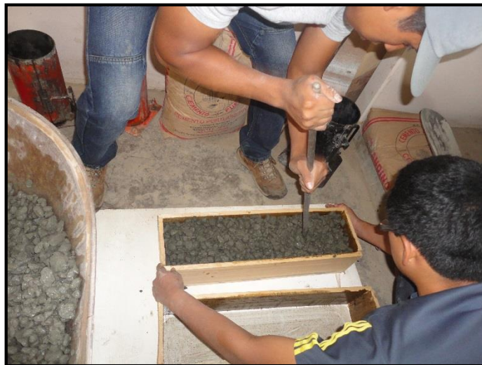
Fotografía N° 10: compactando las viguetas de concreto.
