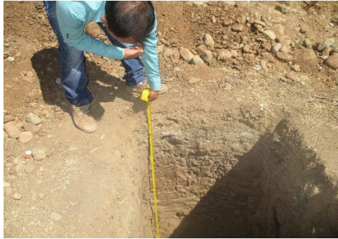
Fotografía N° 14: calicata para estación de prueba.
