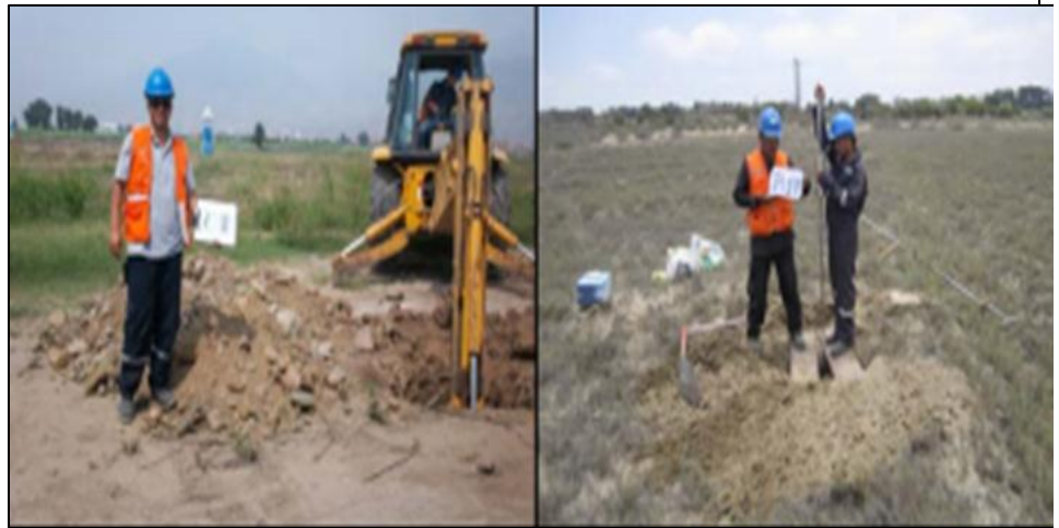
Fotografía 7: Estudios de Geotecnia Exploración en campo excavaciones de calicatas para estudio de suelos
