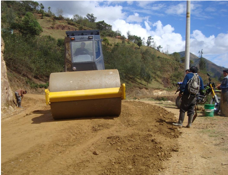
Fotografía N°11 – Se puede apreciar al rodillo vibratorio realizando los trabajos de compactado
