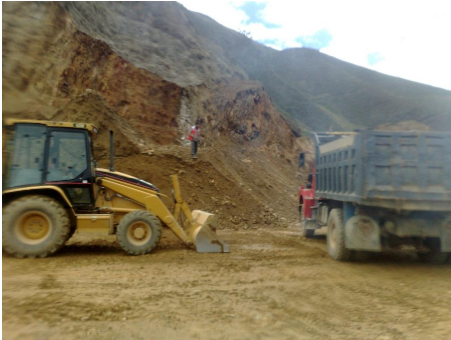
Fotografía N°07 – Se puede apreciar al personal de indicación y maniobras dirigiendo el proceso de carguío. .
