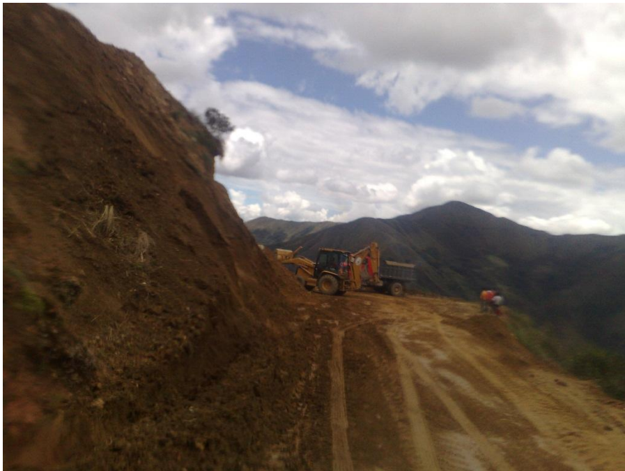
Fotografía N°06 – Se puede apreciar al personal de indicación y maniobras realizando la supervisión de los trabajos.
