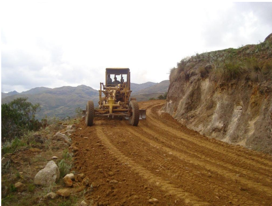
Fotografía N°10 – Se puede apreciar la motoniveladora realizando los trabajos de corte y perfilado
