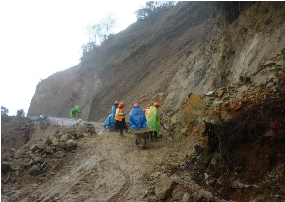
Fotografía N°12 – Se puede apreciar a los trabajadores realizando la descolmatación y la limpieza de cunetas
