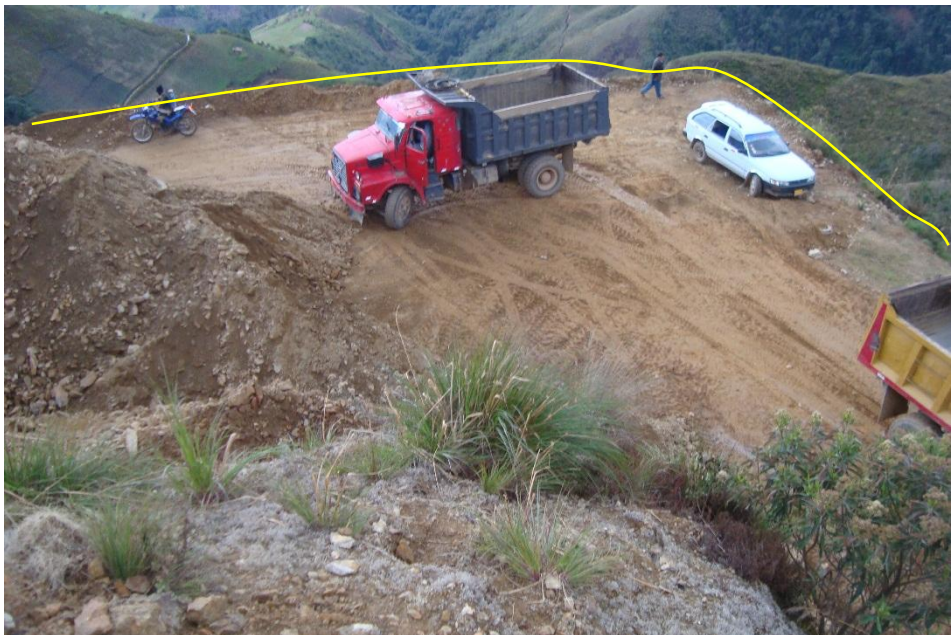
Fotografía N°02 – Se puede apreciar la ubicación de la cantera y el patio de carguío señalizando la zona de trabajo
