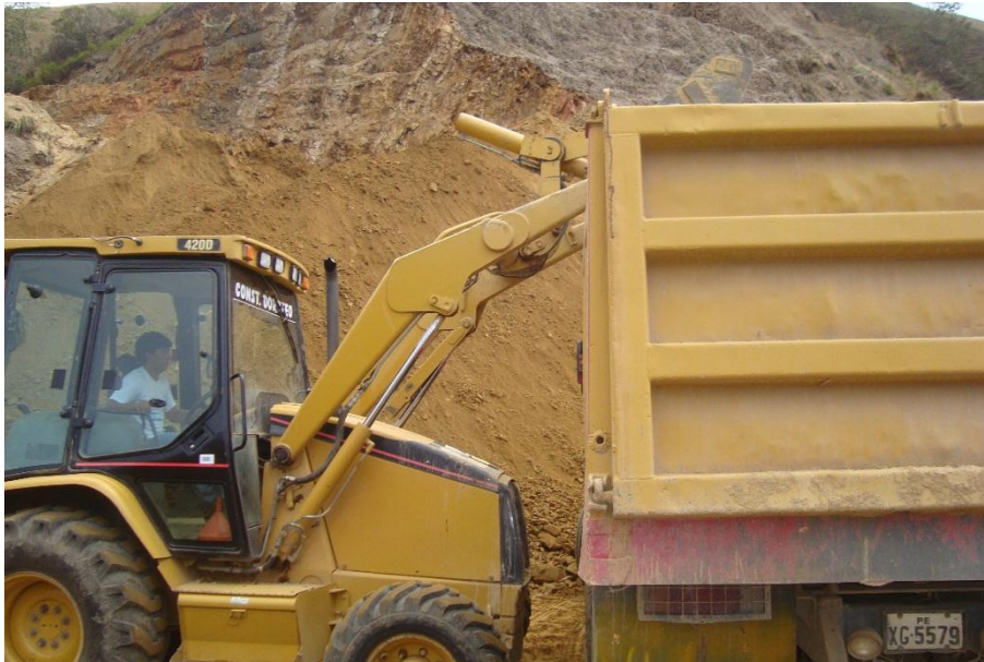
Fotografía N°09 – Se puede apreciar al personal de indicación y maniobras dirigiendo el proceso de carguío. .
