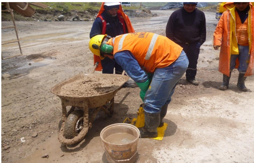
Se aprecia en la imagen al personal de la planta de UNICON
