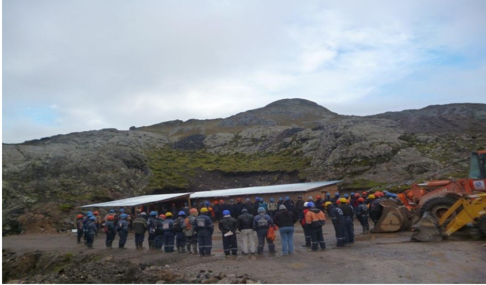
Se aprecia en la imagen la charla de inducción a los trabajadores
