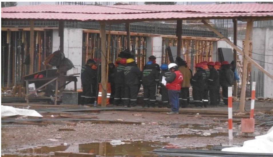
Se visualiza en la imagen la inspección del llenado del AST en el área de trabajo
