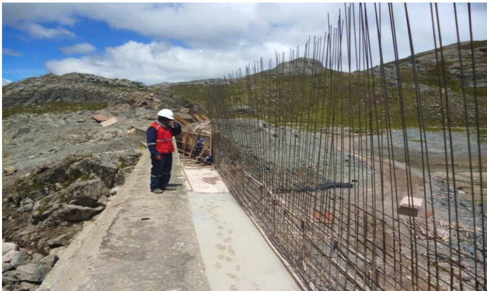
Se aprecia en la imagen la inspección del área de trabajo antes de inicio de la labor.
