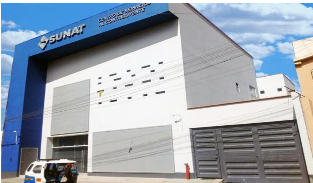
Obra concluida SUNAT – HUANUCO.
