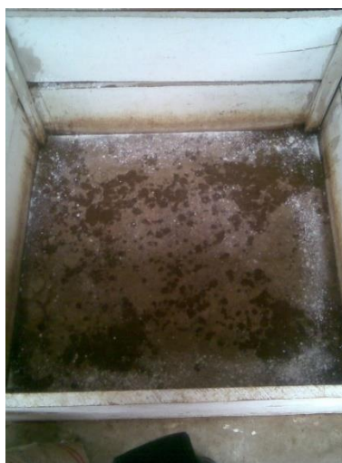
FOTOGRAFIA Nº 03 - 04 - 05: LIMPIEZA DE LAS POZAS A UTILIZAR
