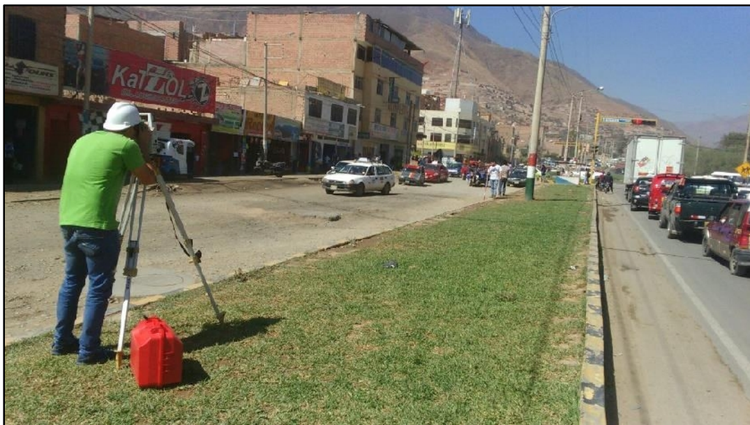
Fotografía N°06: Tomando los datos topográficos.
