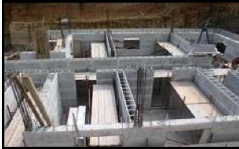
FIGURA 05: Edificación con Sistema de Muros Estructurales
