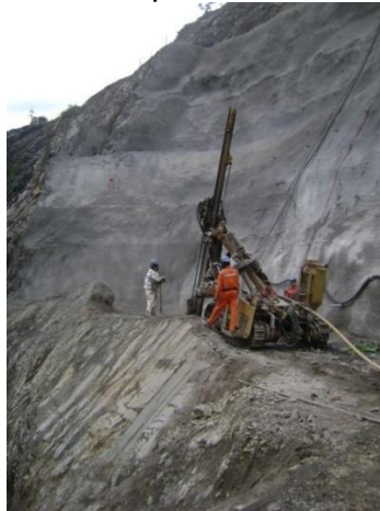
Imagen N° 2.20: Track Drill perforando taladros de producción
