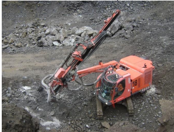
Imagen N° 2.22: Rock Drill DX 680, perforación secundaria.
