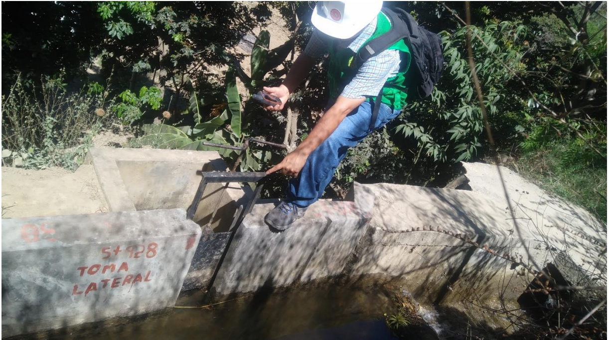
Figura 18. Tanque de Captación situado al lado de la acequia en huachog
