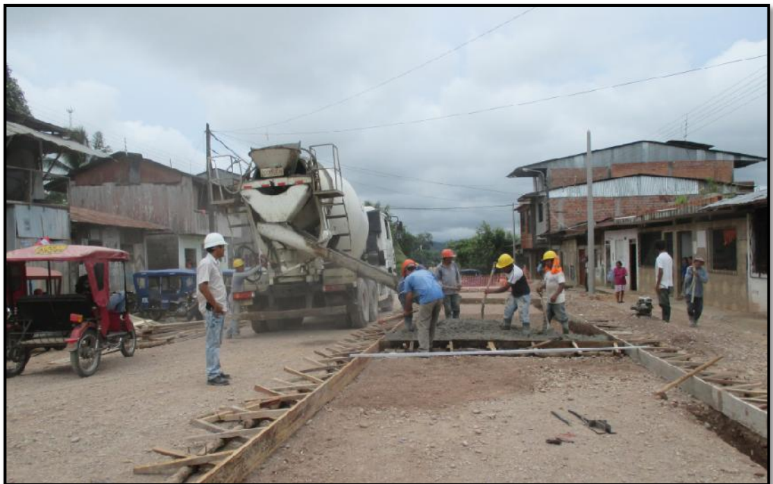
Figura 33: Vaciado por franjas de losa de pavimento
