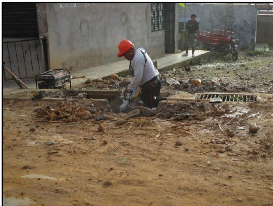
Figura 13: Demolición de Canaleta mal ejecutada
