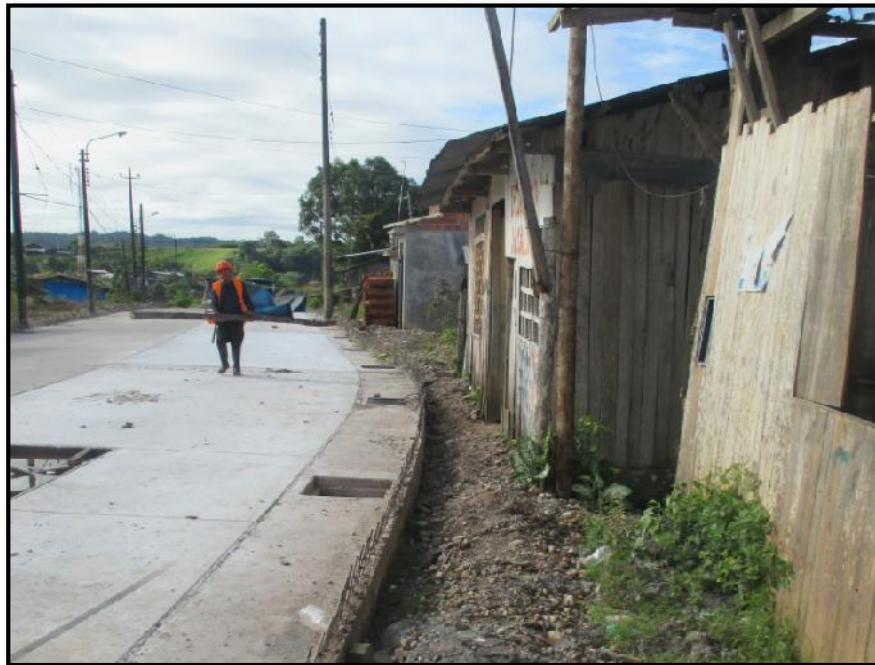
Figura 14: Transporte de Materiales ineficiente
