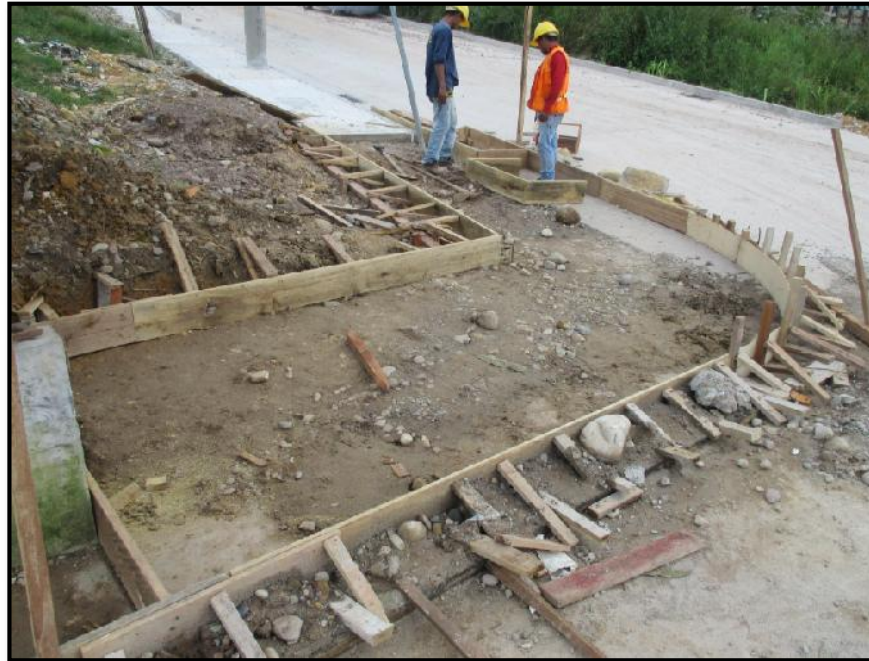
Figura 16: Esperas debido a la falta de Instrucciones
