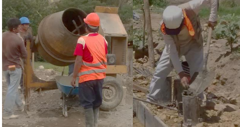
Fig. N° 19: Toma de Nuestras del Concreto Fresco.
