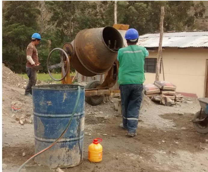
Fig. N° 13: Mezcladora de Concreto.
