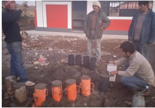
Fig. N° 21: Elaboración de Probetas Cilíndricas de Concreto.
