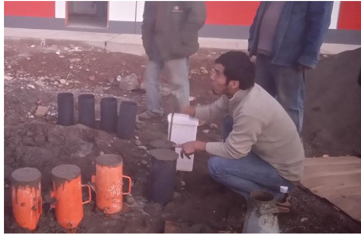
Fig. N° 4: Llenado y Varillado del concreto.
