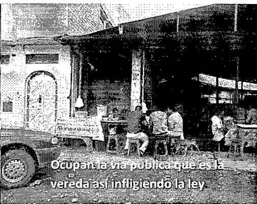
Tiene una cobertura ligera estructurada con listones de eucalipto provisionalmente
