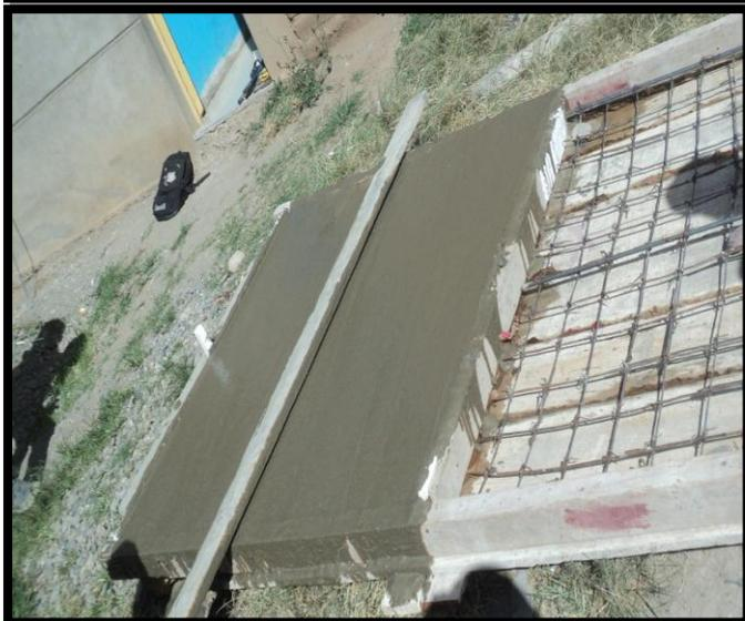
Estamos nivelando con la madera (regla) el concreto, para que salga un espesor a 8 cm
