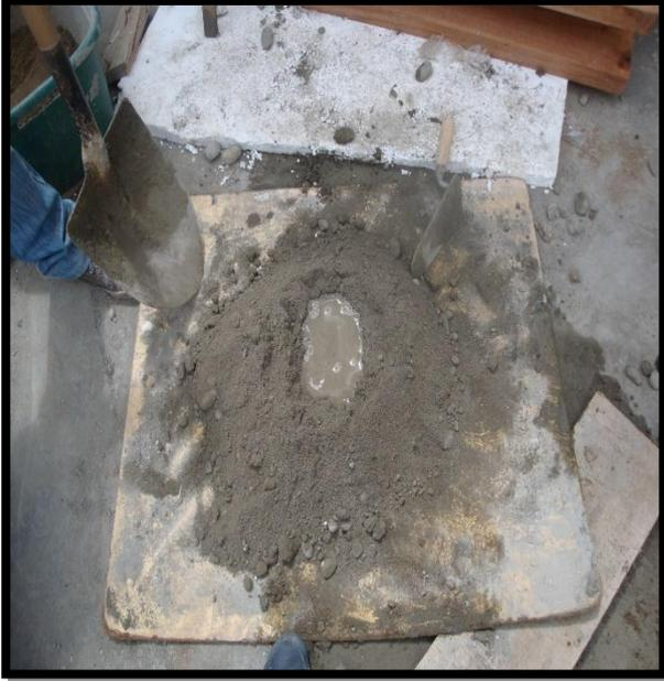
6. Empezamos a elaborar el armado del muro de 1,20m x 1,20m colocando el mortero con las respectivas latas
