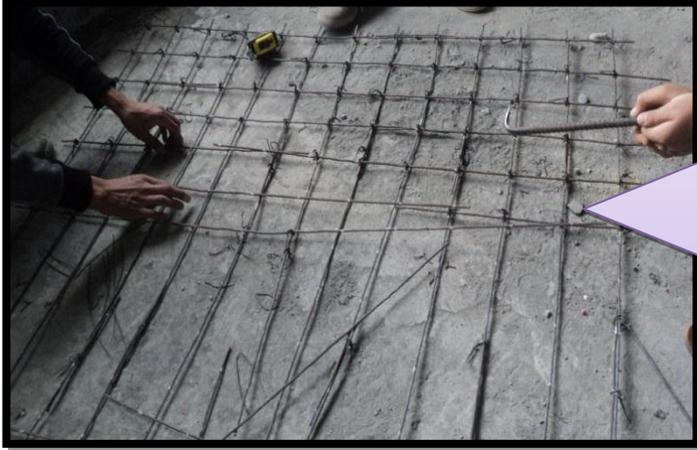
Ajustando cada nudo utilizando la herramientas adecuadas como: tortol, Wincha, cizalla, alicate
