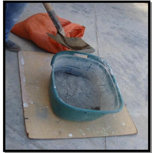
5. Hacemos la mezcla respectiva de cemento y el hormigón, donde cada tres palas de hormigón una de cemento.
