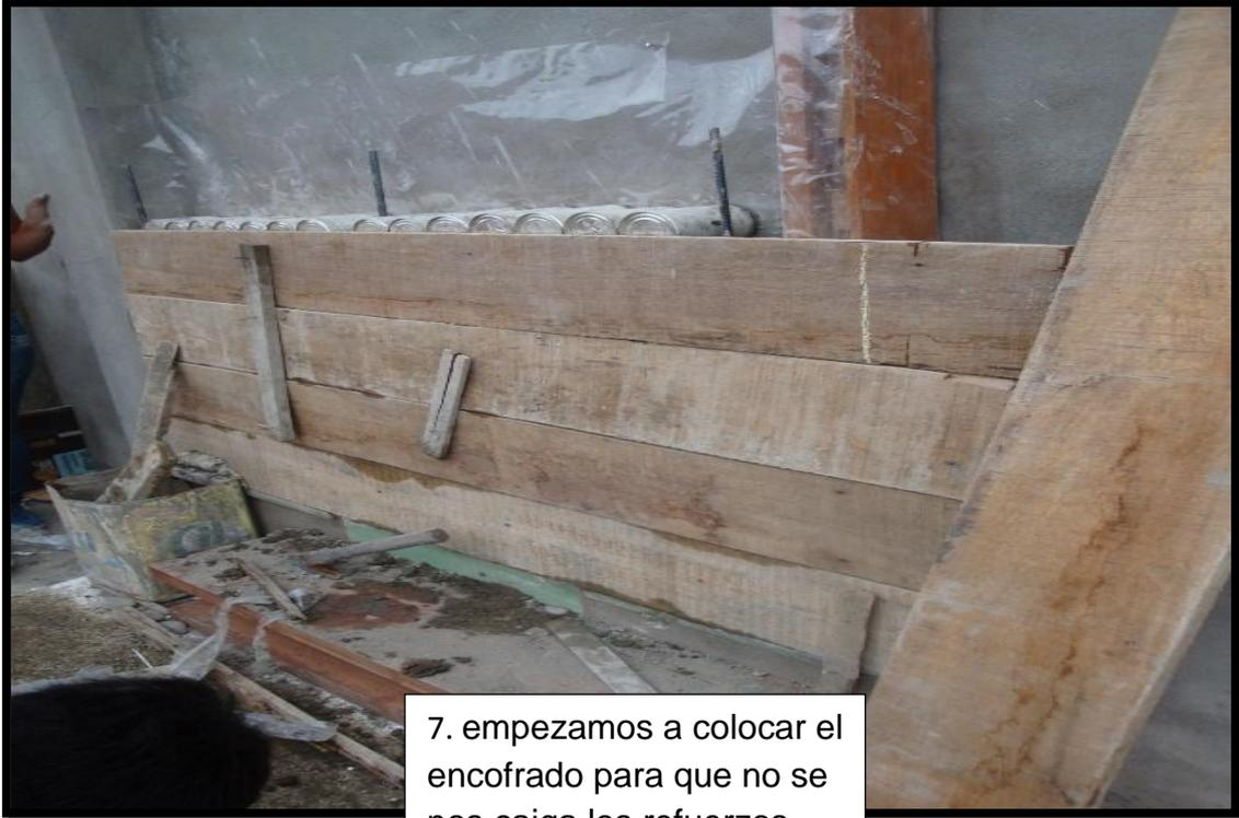
7. empezamos a colocar el encofrado para que no se nos caiga los refuerzos horizontales y verticales
