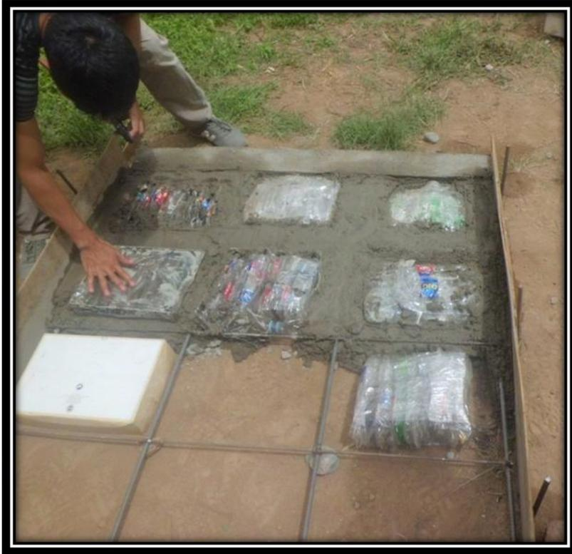
❖ UNDECIMO PASO: secado del muro y curado del concreto.
