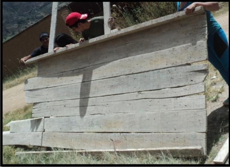
Luego se procedio a encofrar con las soleras de menor longitud y tecnopor
