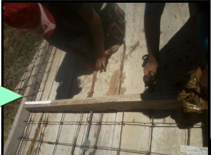
Cubriendo las aberturas en la tabla con bolsa de cemento para evitar el filtro del concreto al momento de vaciar.
