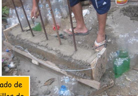
Encofrado de los ladrillos de botellas
