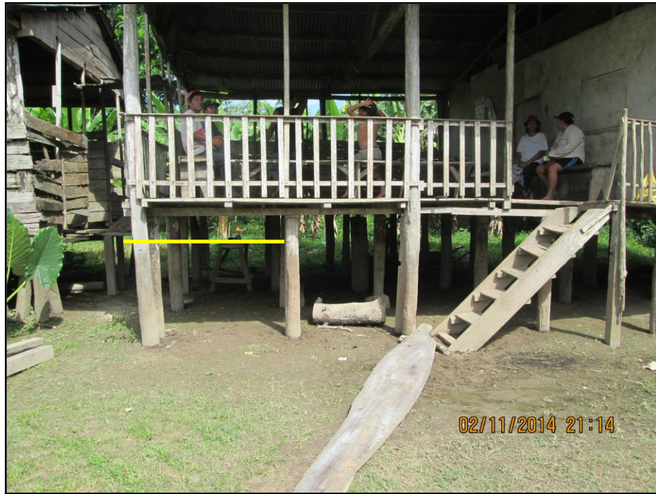
Figura Nº 25: Altura de máxima inundación en el caserío Tahuantinsuyo
