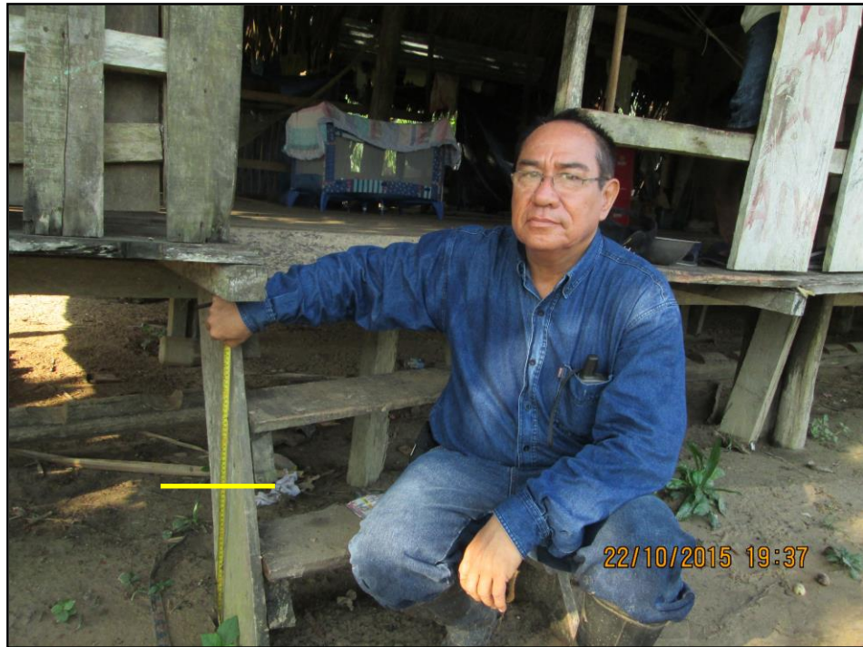
Figura N° 27: Altura de máxima inundación en el caserío Nuevo México.
