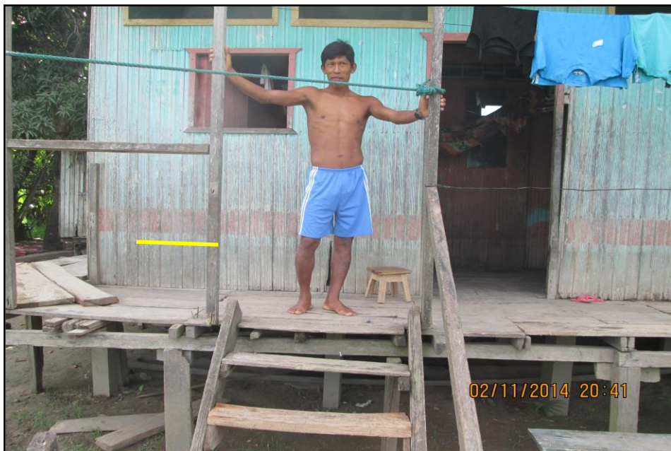
Figura N° 24: Altura de máxima inundación en el caserío Nuevo Ucayali
