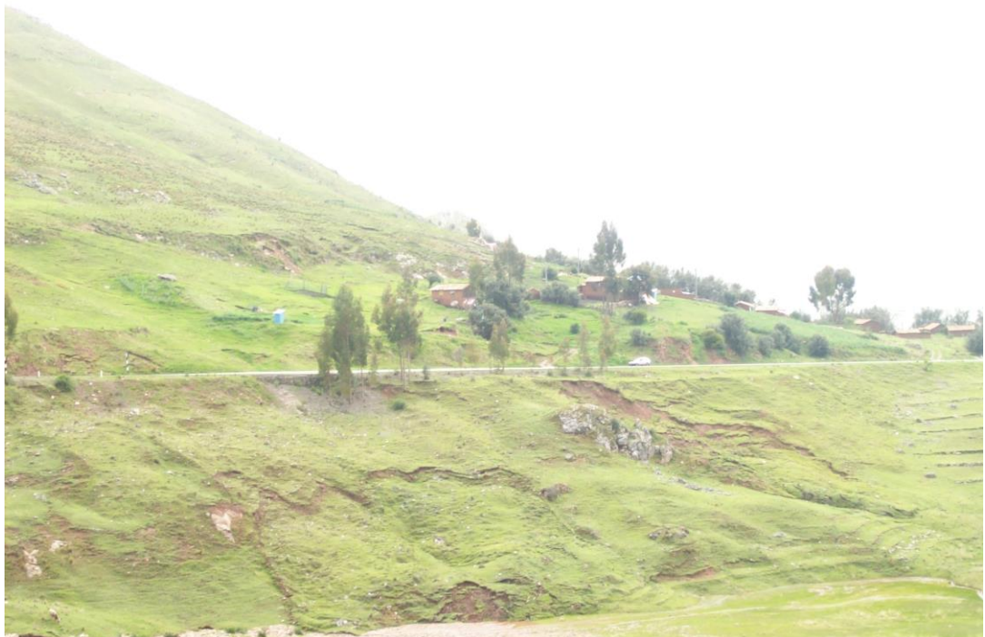
Foto N° 03: Elaboración propia, movimiento de masa de suelo en la parte adyacente de la carretera Km 65+340 Huancavelica Izcuchaca, ubicada en el sector I de la comunidad de Antacocha.
