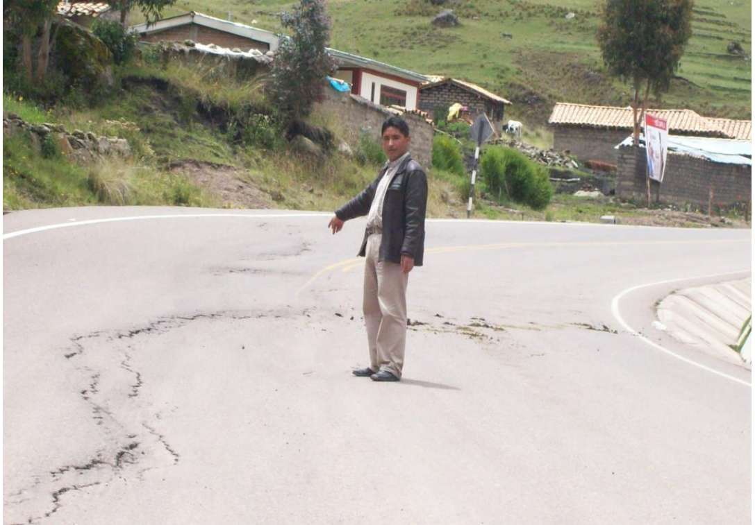
Foto N° 07. Movimiento de masa en la plataforma de la carretera asfaltada Huancavelica-Izcuchaca.
