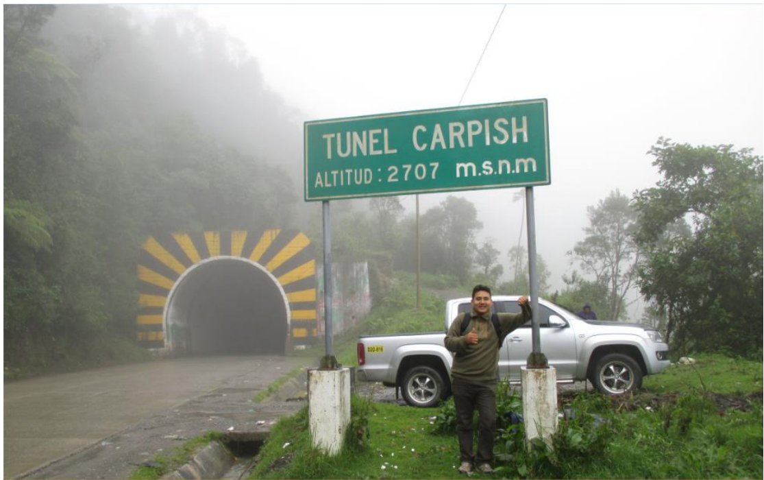
Foto 5: Tunel de Carpish – Carretera Huánuco Tingo María
