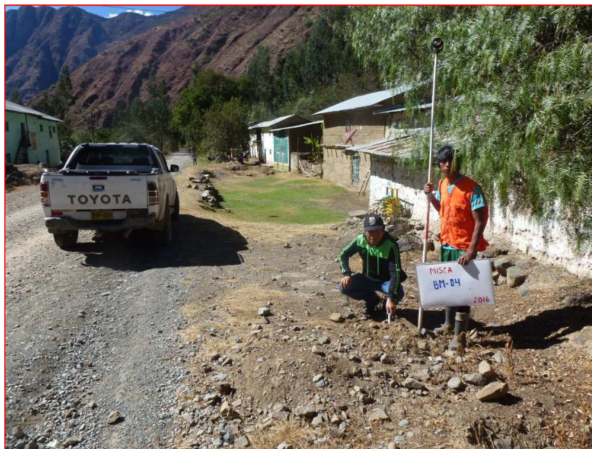
En la Vista Fotográfica se aprecia el BM-04, Instalado en las coordenadas ESTE=350703.3275 NORTE=8856969.8077 COTA=2553.1257 m.s.n.m.
