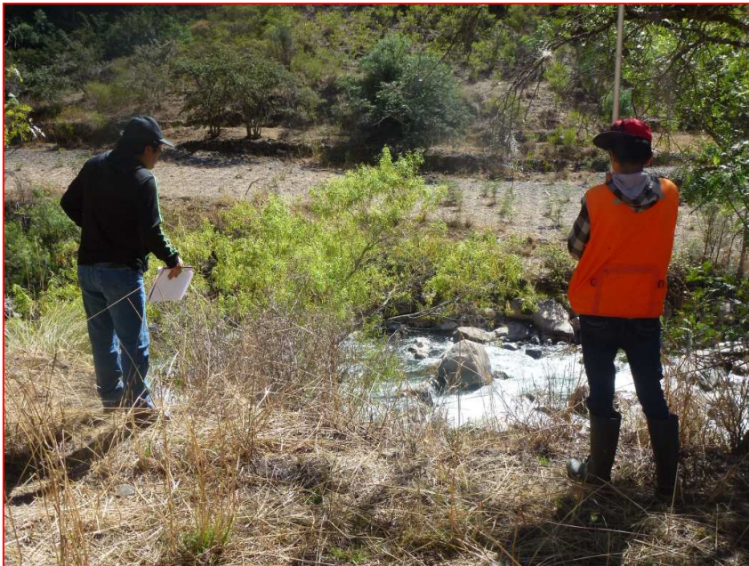
En la vista fotográfica se aprecia al personal técnico desarrollando trabajos de topografía
