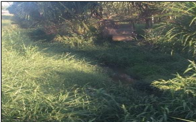
Foto N°06: Trabajo de topografía, en el caño 02.
