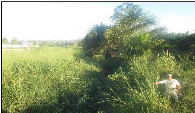
Foto N°05: Trabajo de topografía, en el caño 01.
