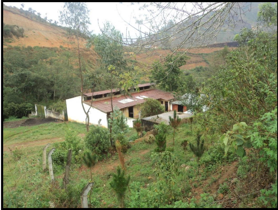
Grafico 13. Instalaciones del Matadero municipal de Panao vista exterior
