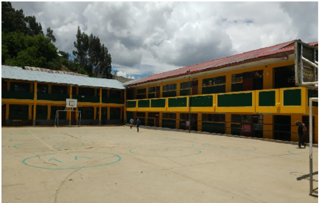
Interior de la I.E. Hipólito Unanue
