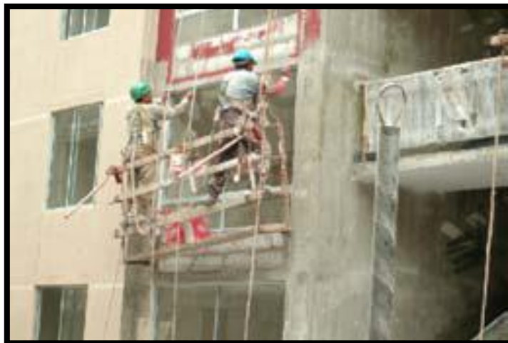
Imagen N° 15. Trabajo de pintura exterior
