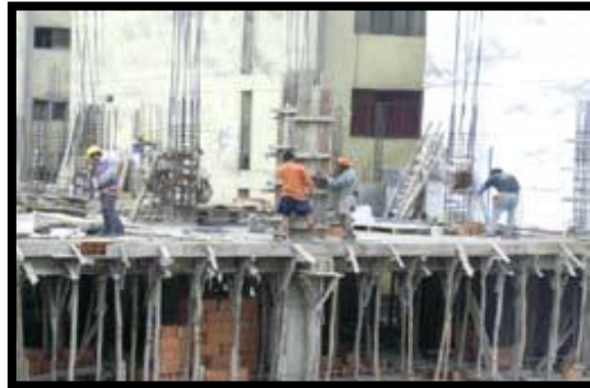
Imagen N° 10. Encofrado y Desencofrado
