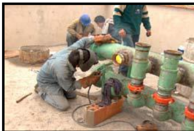
Imagen N° 14. Soldadura en instalaciones electromecánicas
