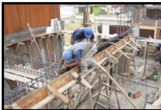
Imagen N° 11. Colocación de acero
