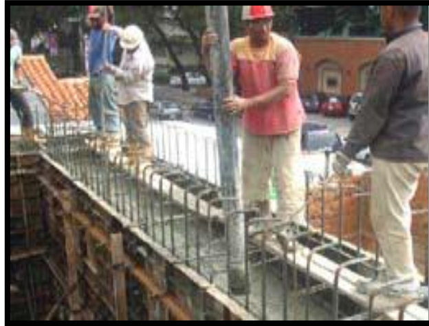
Imagen N° 13. Vaciado de Concreto
