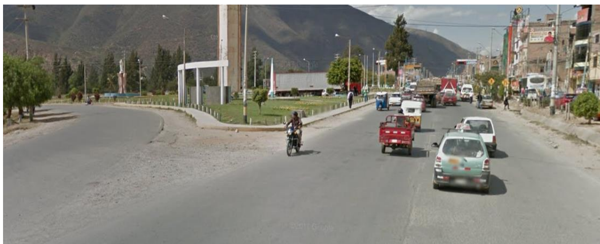
Figura 46: Estado actual del Ovalo de Cayhuayna.
