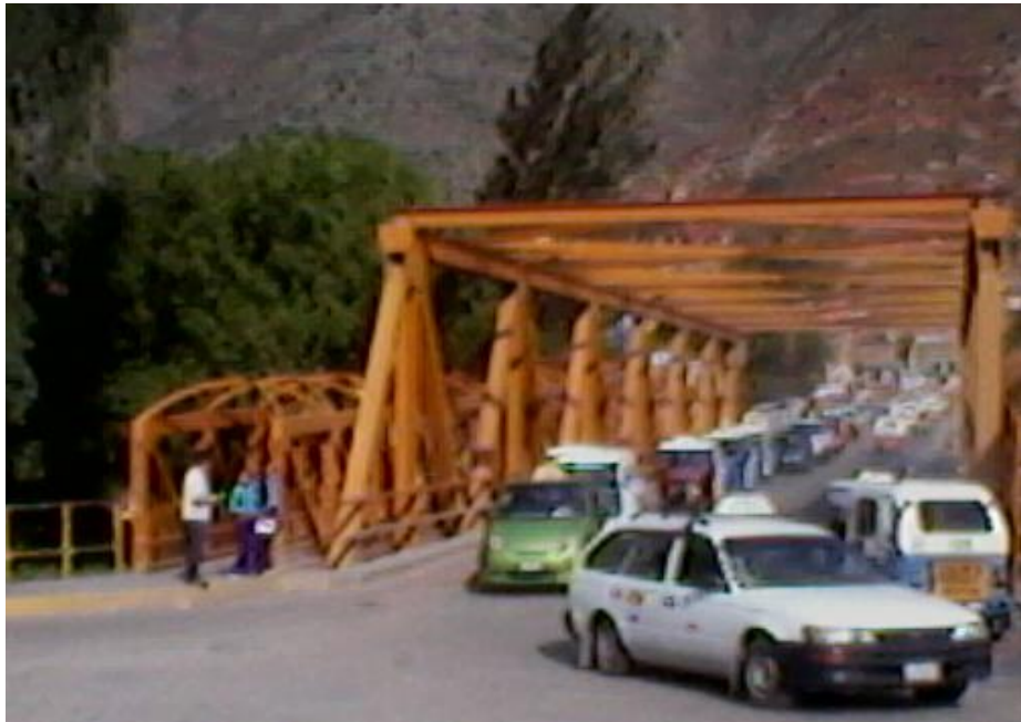
Anexo Foto 1: Toma de datos de vehículos, intersección 1 (ingreso al puente): vía que contiene al Puente Pavletich, acceso de Puente Pavletich hacia Jr. 14 de agosto (mayor flujo vehicular).
