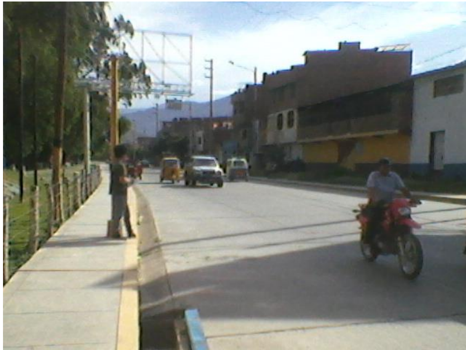
Anexo Foto 3: Toma de datos de vehículos, intersección 1 (ingreso al puente): vía malecón Leoncio Prado, acceso hacia Puente Esteban Pavletich.
