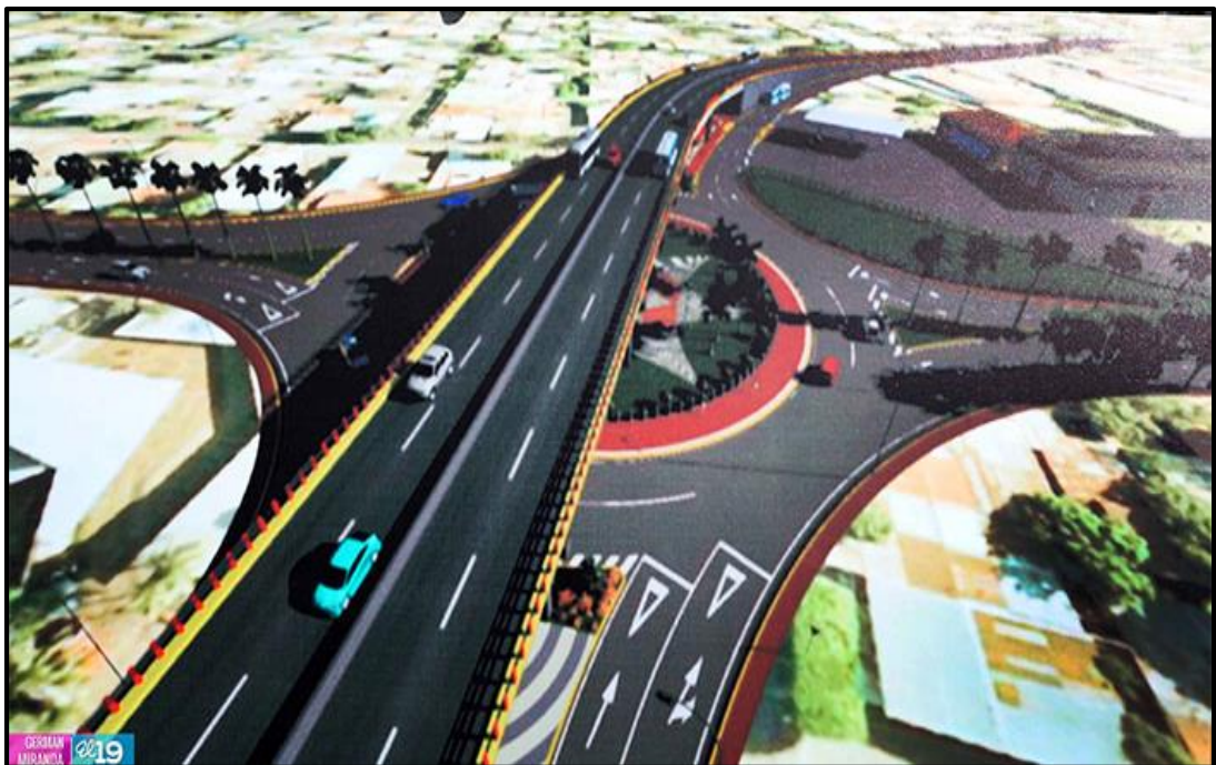
Figura N° 32: Vista típica en 3D de una rotonda a desnivel superior, similar a lo planteado en la intersección 02. Fuente: Portal web fromnicaragua.com.
