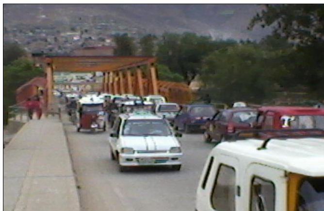
Figura N° 4: Se observa el tramo que contiene al puente Esteban Pavletich, con alto tráfico vehicular en hora punta. Fuente: Elaboración propia
